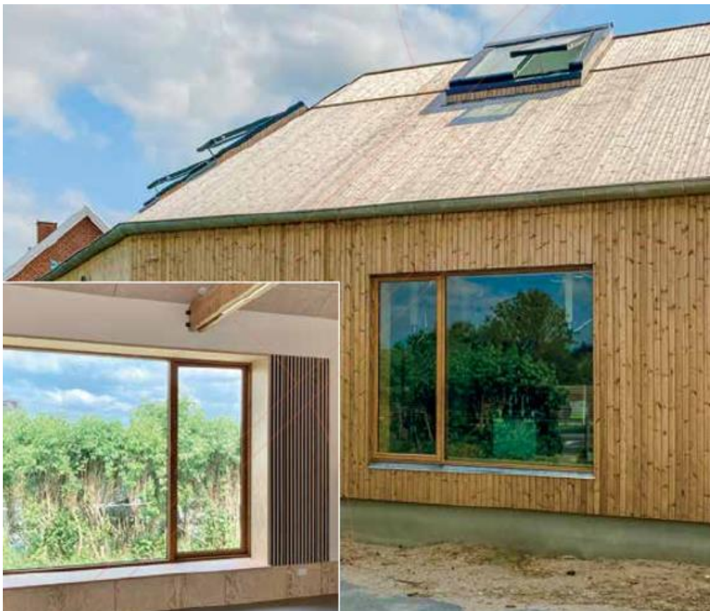
Figur 5.8. Facadeløsning med NOTECH udefra på Feldballe Friskole med oven-vindue, kipvindue med styringssystem fra WindowMaster.
