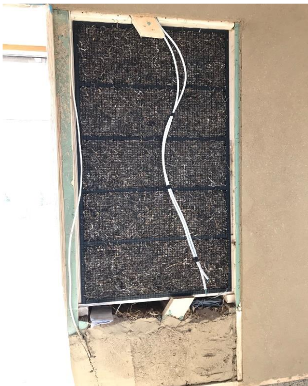
Figur 4 – Billede af ålegræselementet indbygget i facadeelement
