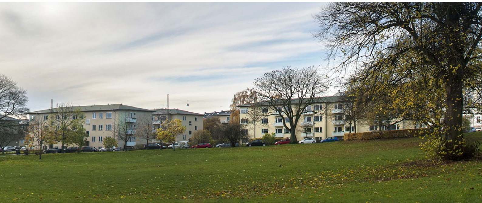
Strandparken set fra Skanseparken. Strandparken 1-3 til højre i billedet fremstår efter renovering i 2012 som den eneste i bebyggelsen med den originale gule facadefarve.
