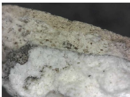
Strandparken 15-17, detalje af facadens overflade, optaget ved 200x forstørrelse.
