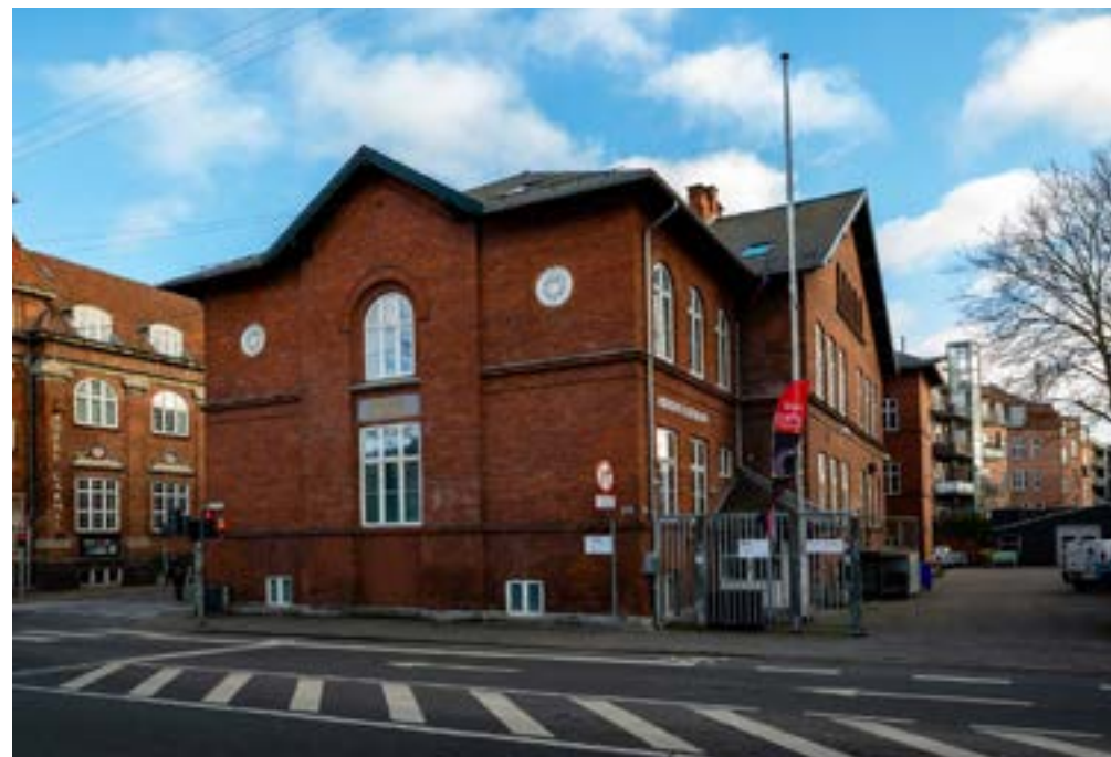
Foto: HALDOR Huset med herberget UngNat
