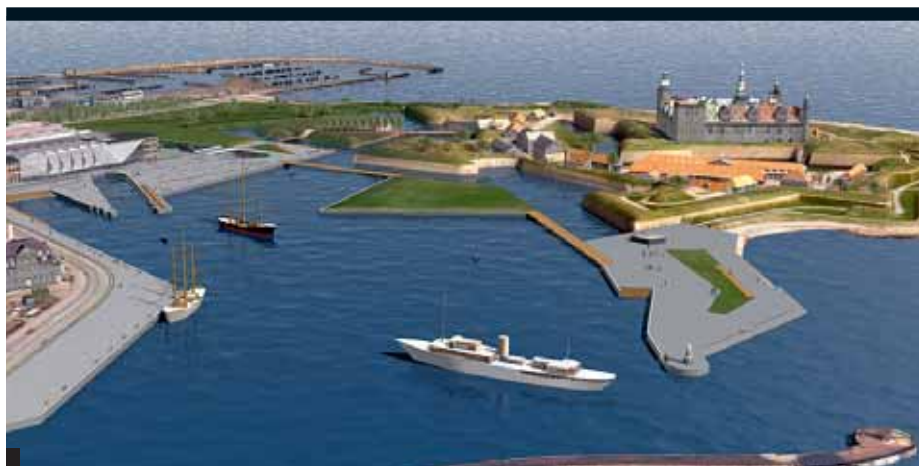
Kulturhavn Kronborg Kronborgs fæstningsanlæg bliver frilagt, og der anlægges en ny ravelin i havnen. Den nye ravelin er en fortolkning af den gamle Scholtens Ravelin, der blev bygget som en del af Kronborgs ydre fæstningsanlæg omkring 1700.
