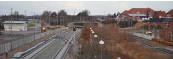
Figur 5.4: De 3 nuværende spor. Spor 1 længst til højre i billedet og spor 3 længst til venstre i billedet. Alle spor ombygges/ sideflyttes i forbindelse med etablering af ny banevej parallelt med spor 1.
