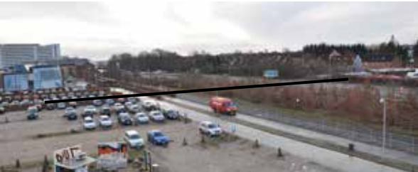
Figur 5.3: Foto set nordvest for den nye banebro. Krydsningen hvor den sorte streg er markeret.
