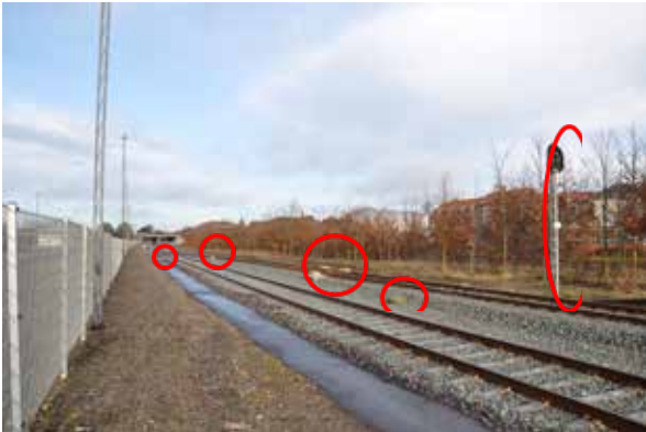
Figur 5.7: Signaler, sporskifte og sporskiftevarmere, brønd og kabelbrønd ved sporskifte.
