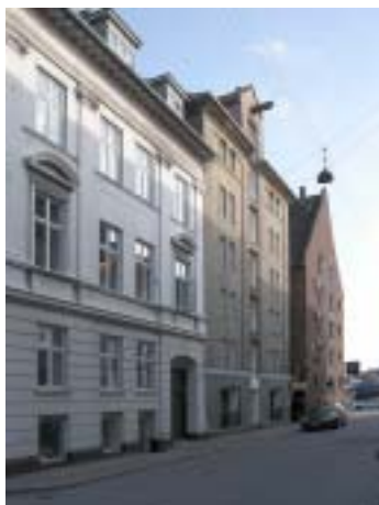
Bebyggelsen i den sydlige del af lokalplanområdet set fra Kvæsthusgade. De to fjerneste pakhuse rummer Hotel Nyhavn 71, og den nærmeste bygning er et klassicistiske borgerhus, som i dag rummer kontorer.
