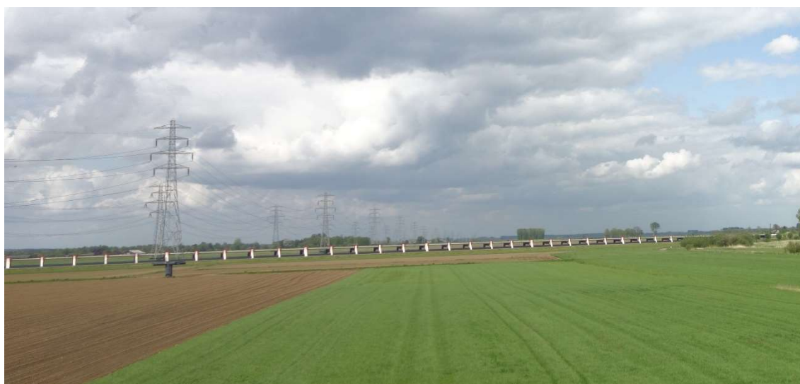
Figur 3.5. Eksempel på område, der er planlagt oversvømmet som led i Room for the river programmet i Holland ved store vandføringer i Rhinen. I baggrunden ses et bygværk på ca 2 km længde, der bruges til at styre, om det næste område også skal oversvømmes. Foto: Karsten Arnbjerg-Nielsen.
