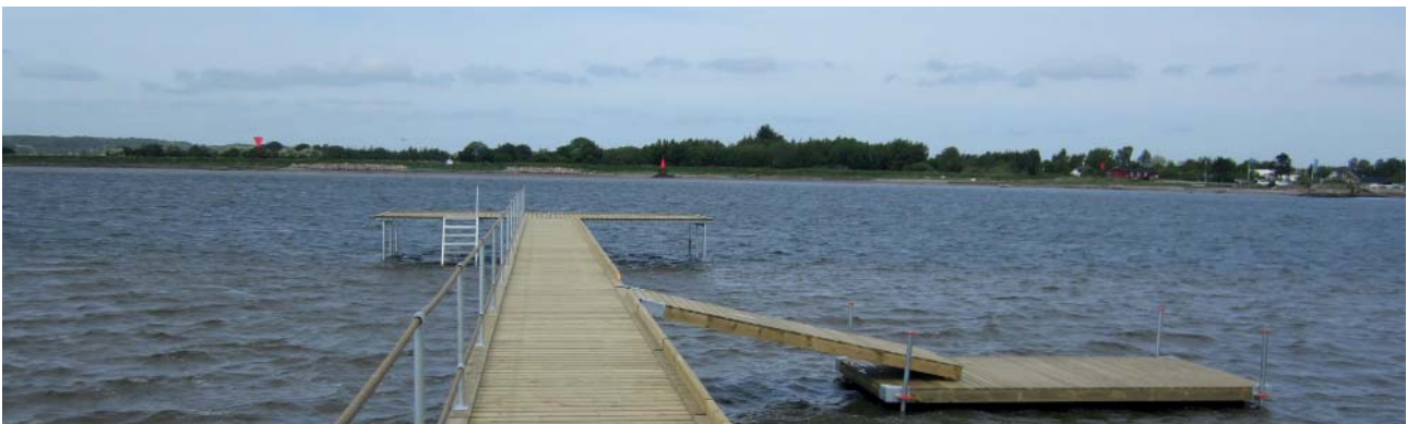
Anløbsbro for kanoer og kajaker ved lystbådehavnen i Udbyhøj syd.
