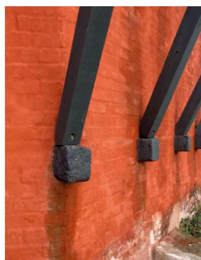
Konstruktion og farve. Kalket mur rødker og kønrøg linolje
