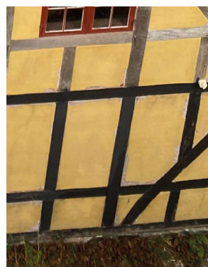
Spærfagskonstruktion med udmurede tavler.
