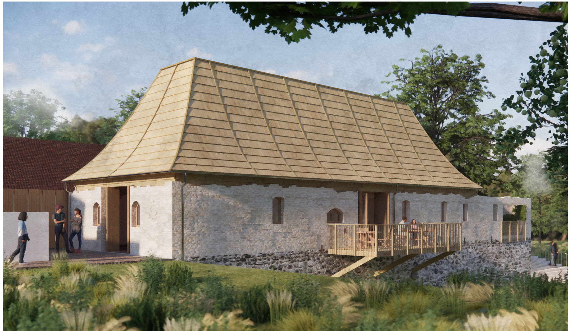
Syd-østlig facade - Phønix Heuset fejrer Møllens arkitektur, udtryk og materialer gennem sin tagkonstruktion og beskytter ruinmuren med sit udhæng
