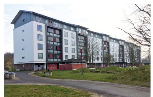
I afdeling 166 har blokkene tagetage, og lejlighederne er hævet over stueetagen. På vestsiden er der inddækkede altaner.
