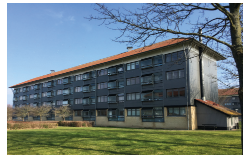
I afdeling 123 er blokkene beklædt med skalmur og metalplader. Blokkenes vestfacader har inddækkede altaner og mindre karnappartier.
