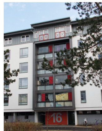
I afdeling 166 er der arbejdet med nedbrydningen af de blokkens skala og horisontale linjer. Dette er gjort ved hjælp af vertikale partier med inddækkede altaner, brug af farver og varierende vinduesformater.
