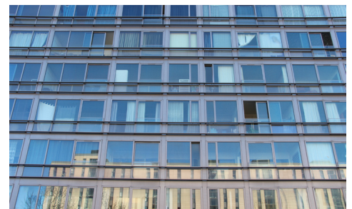
Altanfacadens spejlende inddækning i glas og aluminium, der underinddeles af lodrette og vandrette afdækninger samt vandrette værn og lodrette glasinddelinger. Dele af glasfacaden kan åbnes.
