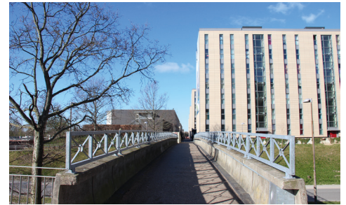
Tilknappede indgangsfacader og gavle. Her et kig fra fodgængerbroen med rækkehuse til venstre og blokke til højre.
