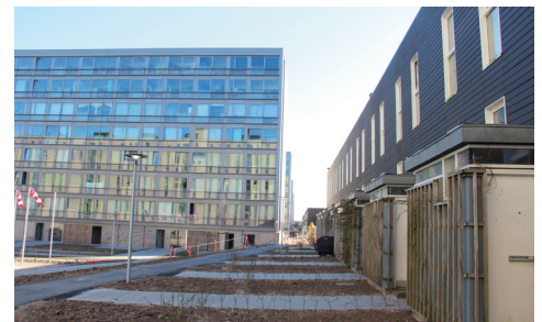
Altanfacader på blokkene og lukkede indgangsfacader på rækkehusene. Spejlinger i de store glasarealer lukker for indkig til facaderne. Kig mod broen, som forskydes af det nye stiforløb.
