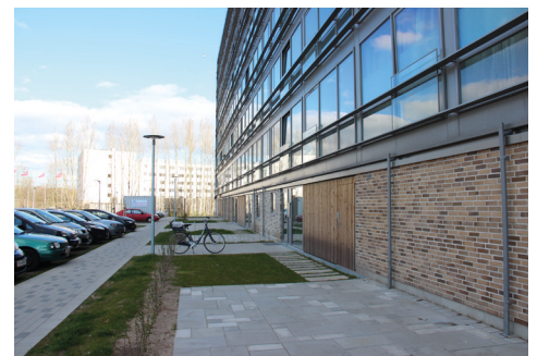
Altanfacade i en nyrenoveret blok, hvor den høje kælder er lukket med tegl, træ og glas.
