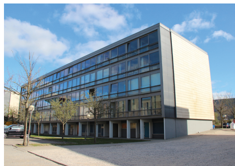
Altanfacade med lukning i glas og aluminium båret af betonsøjler, der danner en åben kolonnade under bygningen.
