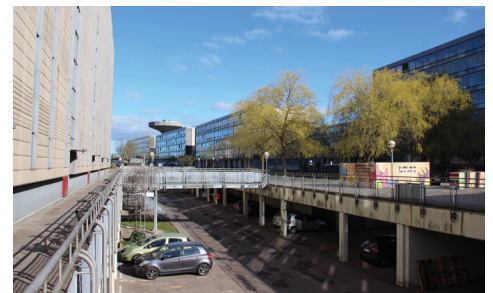
Det oprindelige gårdrum med kig til parkering i underetagen. Til venstre et småt fodgængerdæk langs indgangsfacaden samt gangbroer til opholdsarealer ovenpå parkeringskælderen.
