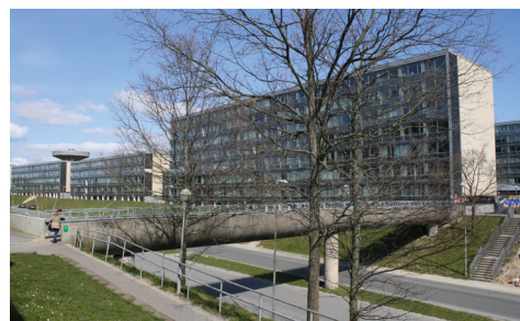
Fodgængerbroen - et svævende betonrør hen over Rymarken - der forbinder bebyggelsen på tværs og understreger bearbejdningen af terrænet.
