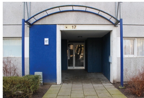
Gadehavegårds tilbagetrukne indgange er typiske for opførelsesperioden, mens det nyere udhæng afspejler nyere tids ønsker om en større differentiering i de store, ofte ensartede montageboligbebyggelser.
