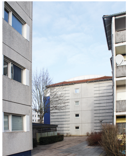
Den dybe husdybde og de modulære betonelementer er karakteristiske for 1970'ernes montagebyggeri. Placeringen af blokkene, så der skabes mindre og mere overskuelige uderum vidner om, at bebyggelsen er opført i sidste halvdel af 1970'erne.
