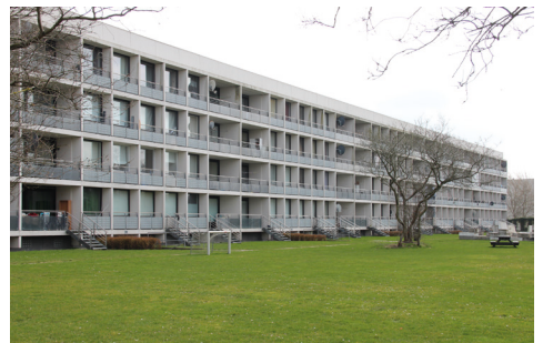
Altanfacade mod vest mod det højtliggende grønne område mellem blokkene. Altanernes dybder og bredder findes i to varianter.
