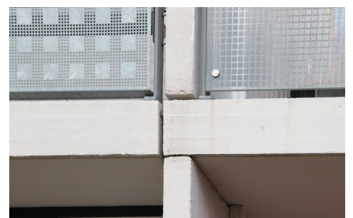
En enkel samlingsdetalje med stoflig kontrast mellem rå brædeforskallet beton og præcist forarbejdet stål.
