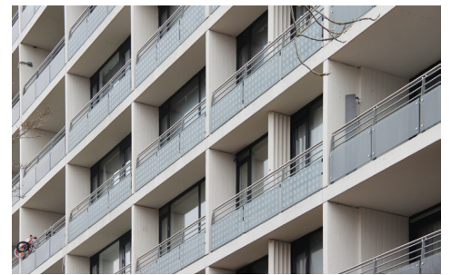
Den synlige betonkonstruktion med tilbagetrukkede facade-partier, skaber en let og spinkel facade med dybde, hvor lys og skygge er med til at tegne facaderne.
