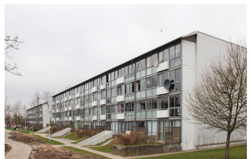
Altanfacaderne på Toveshøj er inddækket med glasfacader i aluminium, der fjerner dybden og strukturen i facaden.
