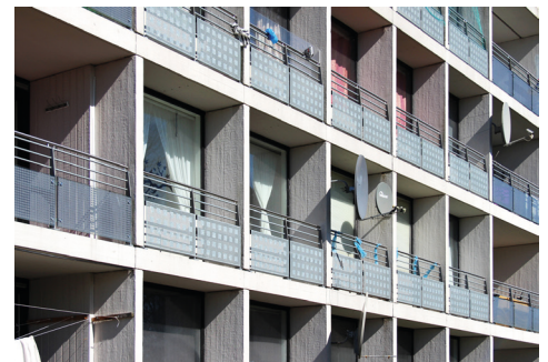
Facaderne består af ganske få elementer. Etagedæk og lejlighedsskel i beton, facadeelementer i træ og glas samt værn i stål og glas. Bræddeforskallings aftryk giver liv til elementernes overflade.
