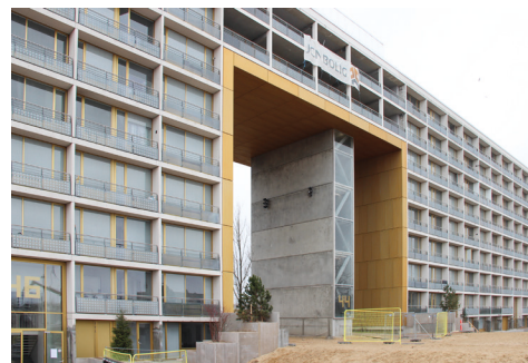
Renovering af blok B4, hvor fodgængerdækket er fjernet og bygningen trukket ned til terræn, men hvor der stadig arbejdes aktivt med bearbejdningen af terrænet og afskærmning af gående og kørende trafik.
