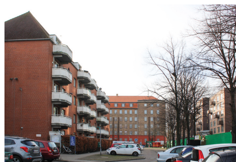
I løbet af 1980'erne blev det igen udbredt at opføre almene etageboligbebyggelser i København, hvor de tidligere var blevet opført i yderkanten af byen eller i forstæderne rundt om København.
