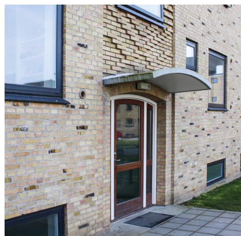
Indgang i afdeling 15. Brugen af enkelte præfabrikerede elementer i de håndværksopførte, murede boligbyggerier var udbredt i slutningen 1950'erne.
