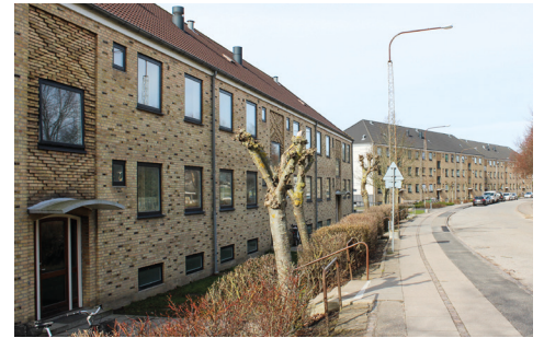
Afdeling 15 fremtræder som en sammenhængende boligbebyggelse i kraft af den gennemgående brug af murværk og de samlende tagflader. Samtidig sikrer forskydningen af blokkene samt bearbejdningen omkring indgangspartierne variation.
