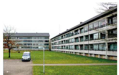
I nogle få blokke kan man stadig se strukturen i de oprindelige facader.
