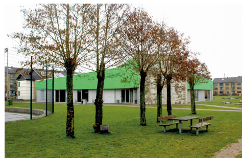
Kvarterhuset ligger i en grøn kile, som i kraft af sin store størrelse og placering langs Cypresvej har en halvoffentlig karakter.
