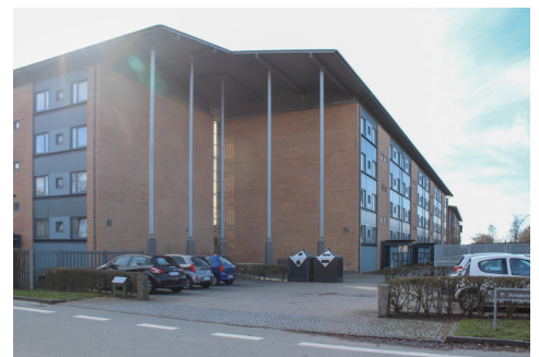
Ringparken blev renoveret i 1990'erne og især tagene, der understøttes af metalsøjler, er typisk for tidens arkitektoniske idealer.
