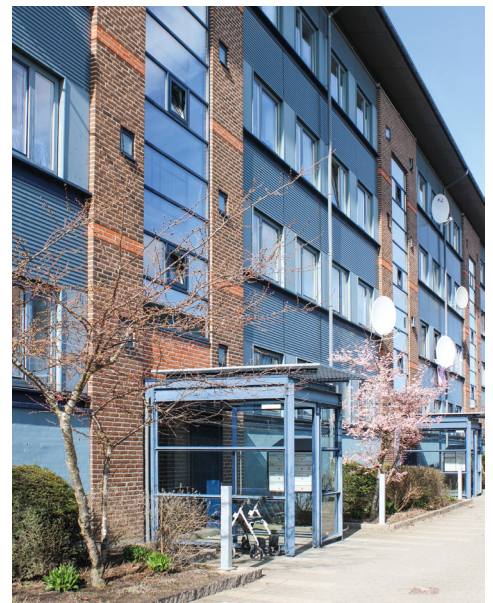
Facaderne med mursten, plader og indgangspartier er fra renoveringen i 1990'erne.
