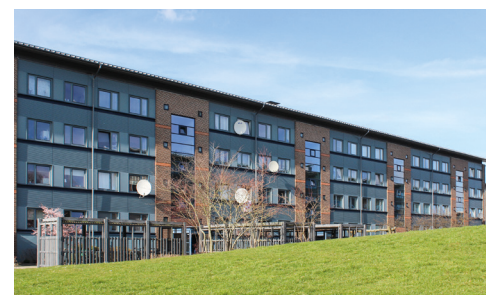
Boligblokkene er blevet renoveret og har fået nye facader med mursten og plader.
