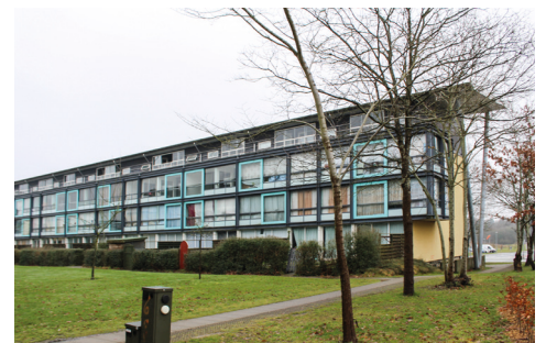
Den nyere bearbejdning af blokkenes facader har medført en opbrydning af de oprindeligt, ensartede industrialiserede facader med forskellige vinduesformater og brug af farver.
