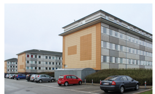
I Skovvejen har udvalgte blokke ligeledes fået en ekstra etage på, så der også er tagboliger. Derudover er gavlene blevet efterisoleret.
