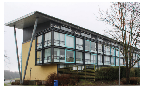
I Skovparken har nogle af blokkene fået en ekstra etage på, så der nu er tagboliger. Derudover er de lukkede altaner ført om hjørnet ved gavlen, og hele havesiden er blevet renoveret.
