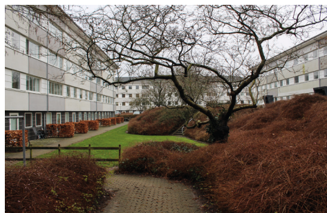
Uderummene i begge bebyggelser er blevet renoveret, og der er en blanding af offentlige, private og halv-offentlige rum.
