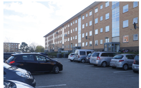
Ankomstfacade med parkeringsareal parallelt med Østerled.
