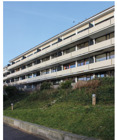
Terrænet er bearbejdet op mod sydsiden af den lange nordlige blok. Stuelejlighederne har egne haver.
