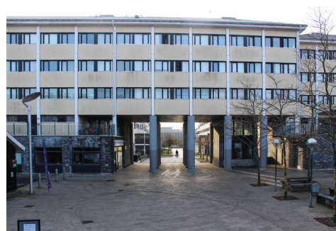
Der er sat skærmteglsbeklædning på parterre-etagen og de oprindelige betonelementer er blevet malede. I forbindelse med hovedindgangen og fælleshuset ved parkeringsarealet er der etableret kontorer i parterreetagen.
