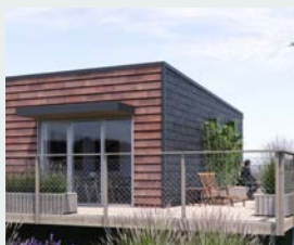
ENF04 KLIMAKASSEN OPFØRT I 2022 86 m 2 1 ETAGE 2 BEBOERE
