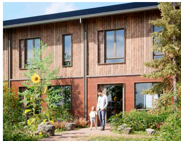
↑ Rækkehusbebyggelsen, som AKF opfører i Brøndbyvester, bygges i en trækonstruktion og isoleres med halm.
