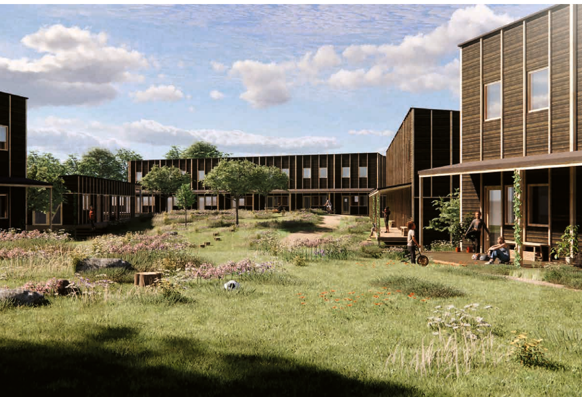
← Lejerbos huse i Helsingør får en facade af genbrugstræ med en brændt overflade. Formen bliver som et ottetal for at skabe en følelse af samhørighed og sammenhold.
