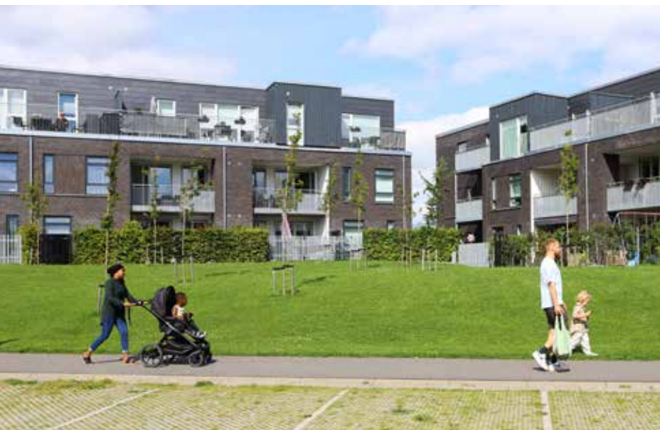
Boligerne i området var generelt nedslidte og havde problemer med fugt og kulde. Efter den omfattende renovering fremstår de som moderne familieboliger.
