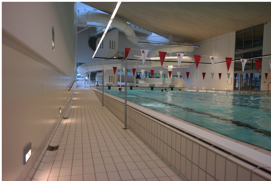
Kanten som nedstigningsmulighed til det store bassin.
