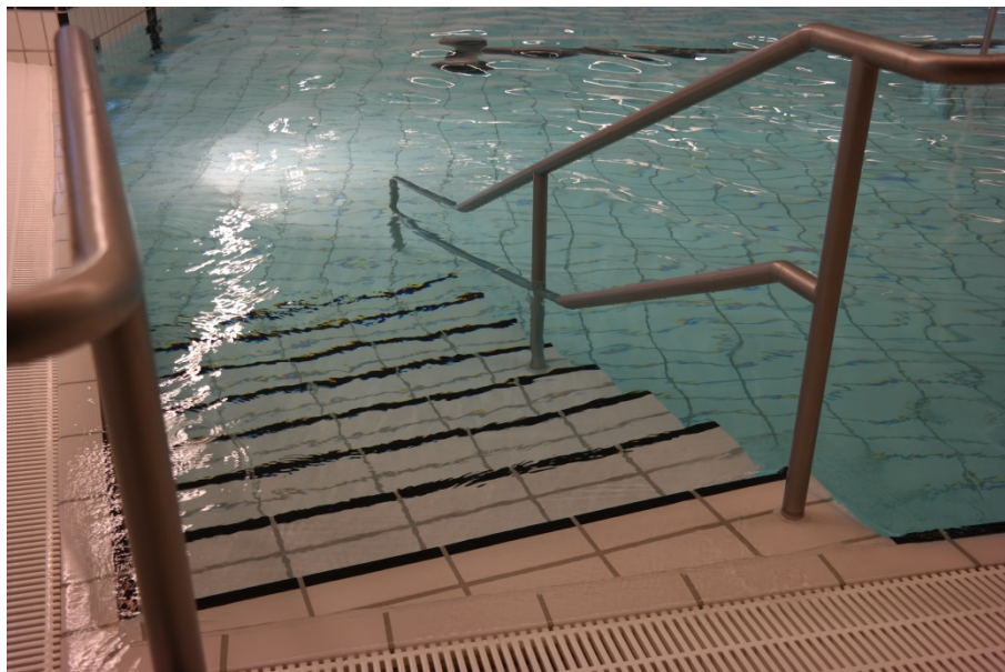
Trappe som nedstigningsmulighed til bassin.
