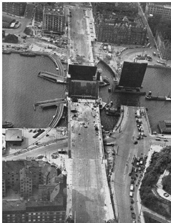
Den nuværende Langebro, med to broklapper, bygges ved siden af dens forgænger i starten af 1950'erne. Bemærk, at jernbanen var placeret syd for den nuværende bro på en lav svingbro.
