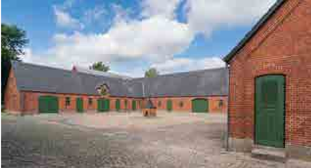
Fra vaskehus og bryggers havde gårdens ansatte adgang til de tre avlslænger, som var moderne og rationelt indrettet. Den lille kvist med luge ind til loftet gjorde det nemmere at bringe foder og korn ind og ud. En tilsvarende luge findes på den modsatte længe. Til højre ses døren til dasset.
