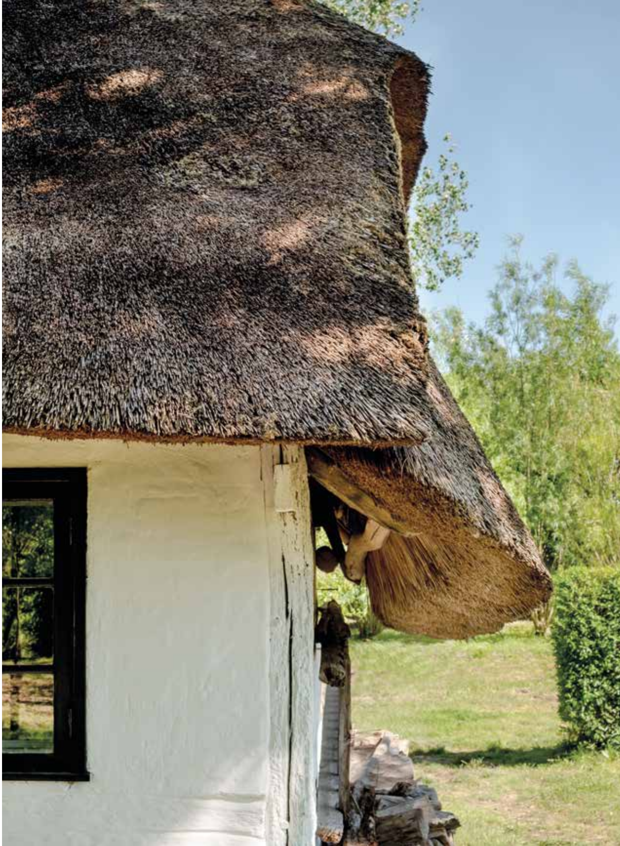
Skynen, hvor stråtaget fra gavlen er trukket ud over en opskalkning af træ, fungerer som et udhæng, der kan skærme redskaber fra vind og vejr.
