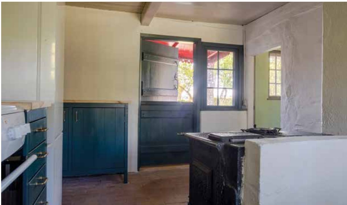
I husets køkken ved siden af døren til gårdspladsen sidder stadig et af de store vinduer, som i en periode prydede østfacaden, og som var årsag til, at løsholten blev sænket. Alle øvrige store vinduer blev udskiftet med mindre vinduer i 1960'erne.
