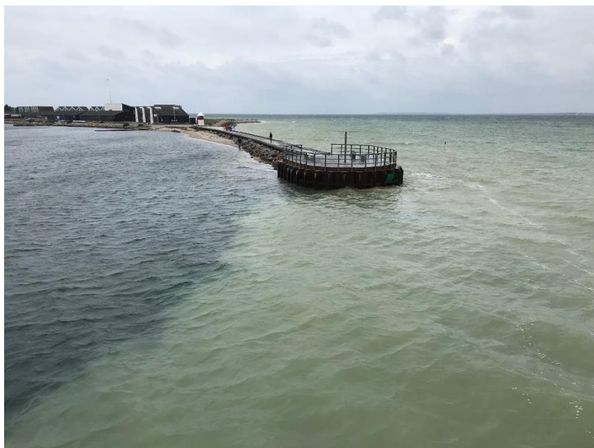
Figur 5.8 Vestlig mole ved havneindsejling til Assens Havn. Billedet er taget mod sydvest ved en sydvestlig vind. Grænsen mellem det mørke og lyse vand indikerer en sedimentsky i vandet, der er transporteret rundt om molehoved. (foto: Ole Knudsen)
