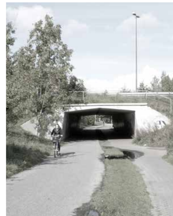
Tunnel under Humlebakken idag
