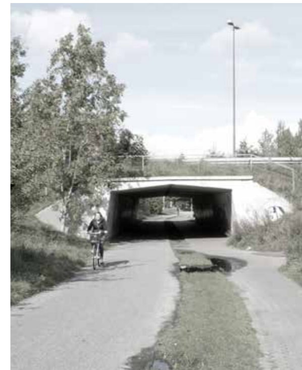
Tunnel under Humlebakken idag
