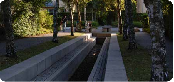
Eksempel på Lar-løsninger, hvor der er lavet forsinkelsesbassin
