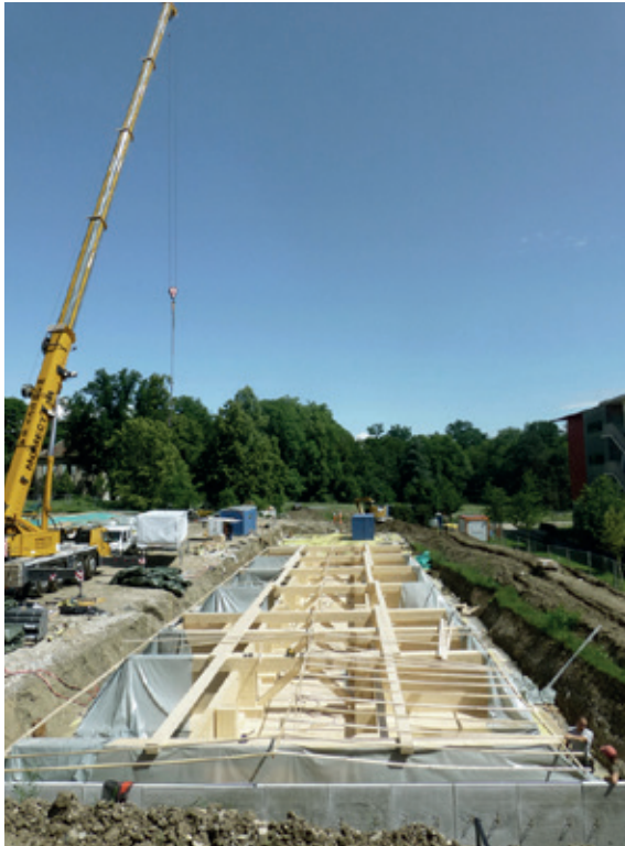
Under midten af bygningen er der en installationsrende, som også er udført i træ. © Enric Rovira
