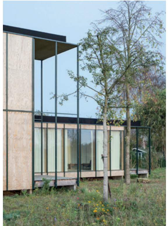
Husets facade fremstår som aluminiumsrammer som kan være fritstående eller indeholde glas, træpaneler eller dørpartier. © GAFPA
