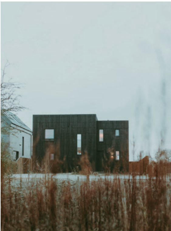
Huset er udført i biogene materialer med en facade bestående af brændt træ. © Lenny Codd
