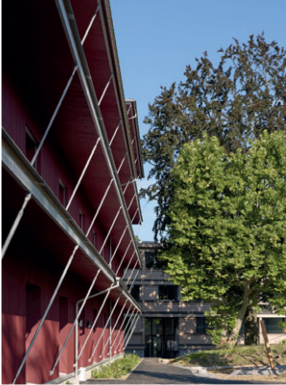
Udkragningerne set tæt på, med stålør udført i samme farve som tagkanten. Sammen tilfører de en særlig let tektonik i relation til en ellers kasseformet bygning og meget regulær bagvedliggende facade. © Yohan Zerdoun
