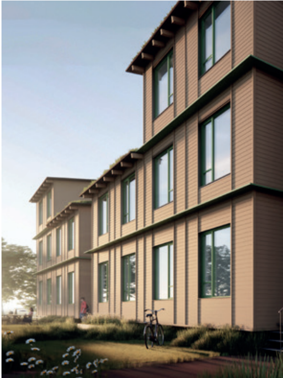
Flammeafbøjere indgår i bygningernes samlede tektoniske udtryk, og forholder sig til tagudhæng og den lodrette listeinddeling i facaden. © CPH Village
