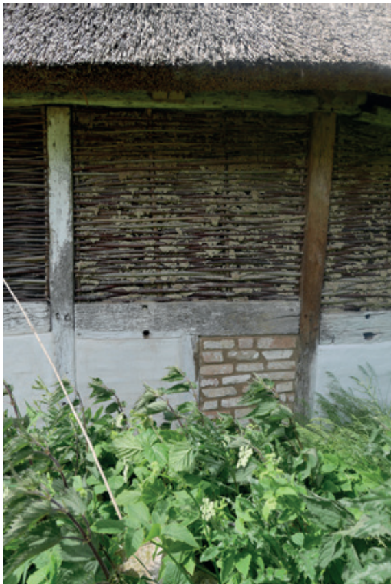
FIG 10: Gården fra Fjelsted i Den Fynske Landsby er en sulekonstruktion, som har været egnskarakteristisk for Fyn. Stolperne er bundet sammen med et indtappet løsholt. I øverste tavler er der isat flettede vidjer, som er lerklinet indefra. Nedenunder opdeler en dok gående fra bundremmen op i løsholtet tavlet i to. Heri er der isat pudsede og kalkede teglsten. © Henriette Ejstrup, 2024
