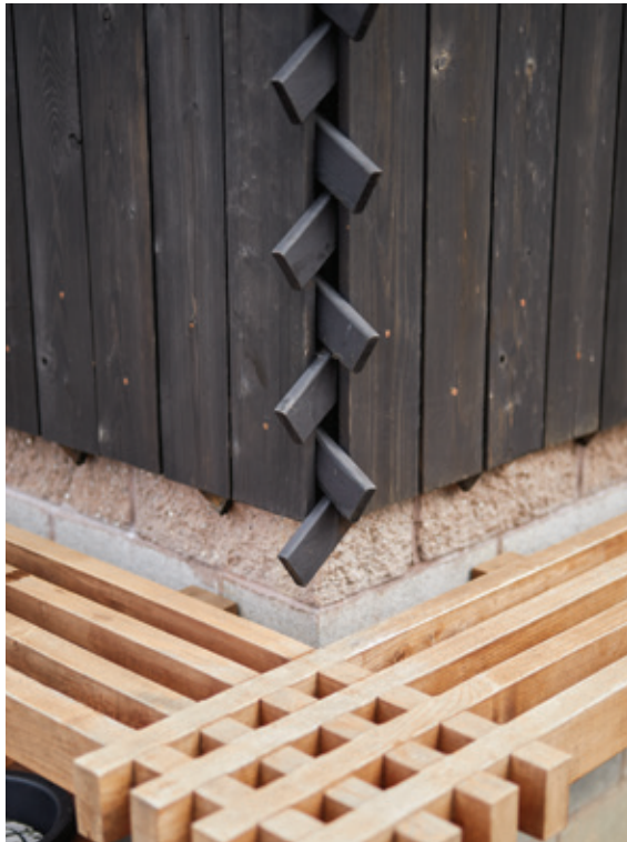
På hjørnerne af huset flettes afstandslisterne fra de to tilstødende facader sammen og bliver til et tektonisk element. På hjørnerne er der tilføjet ekstra lister til at lukke hjørnet. © Ty Cole
