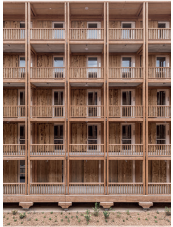
Bygningerne er synligt hævet over terræn på siderne som peger ned af bakken. Overgangen mellem bygningerne og terræn er accentueret af elementer som næsten ligner kapitæler på en søjle, som i dette tilfælde befinder sig under jorden i form af træpælefundamentet. © Marcel Kultscher
