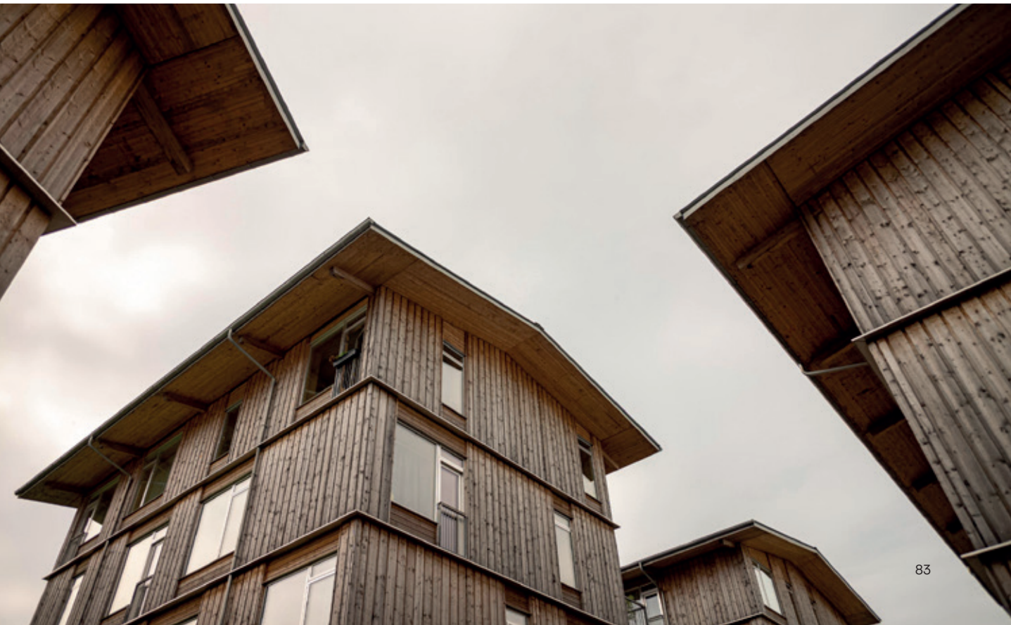
Over og under vinduerne er brædebeklædningen konsekvent vandret modsat den lodrette beklædningen mellem de etagevise vandbrædder. Det karakterfulde udhæng er udført i CLT elementer med brædder parallelt med førnævnte vandrette beklædning. © Helene Høyer Mikkelsen
