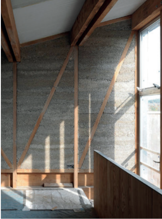
Både bindingsværket og hampekalks overflader er synlige. Begge materialer ligger i samme niveau. © David Grandorge & Oskar Proctor
