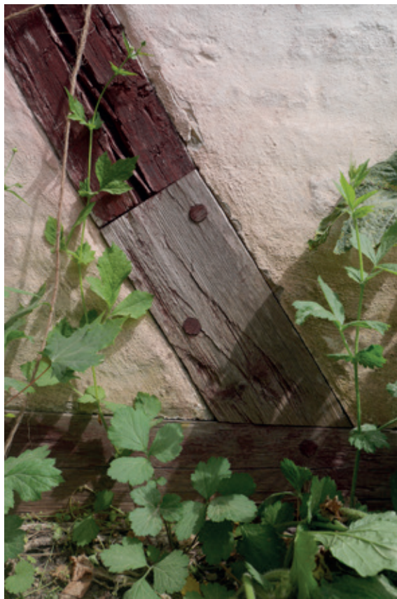
FIG 23: Partiel reparation af skrånstiver i bindingsværkskonstruktion i Den Fynske Landsby. © Henriette Ejstrup, 2024
