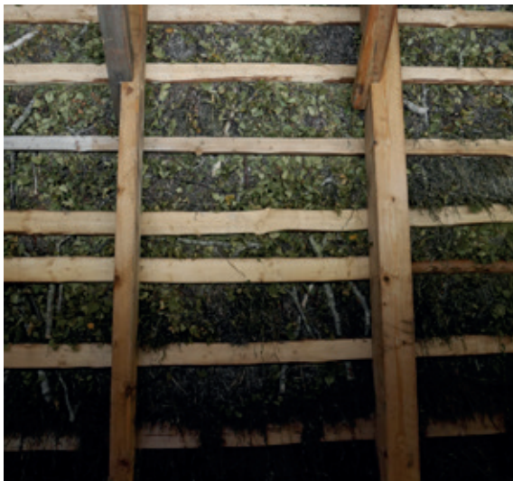
FIG 18: På Læsø har det været anvendt at bruge birkegrene som brolag. Her ses teknikken på på Lynggården. © Henriette Ejstrup, 2024
