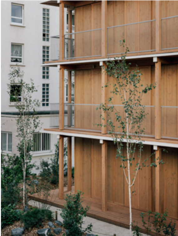
Vedligeholdelsesgang foran facaden, med lukkede skodder. Skodderne er monteret med et skydebeslag dermed at de ikke blokerer altangangene når de er åbent. Gelænderne er lakeret i en dæmpet grå farve og lader trækonstruktionerne spille hovedrollen i facadeudtrykket. © Charly Broeyz
