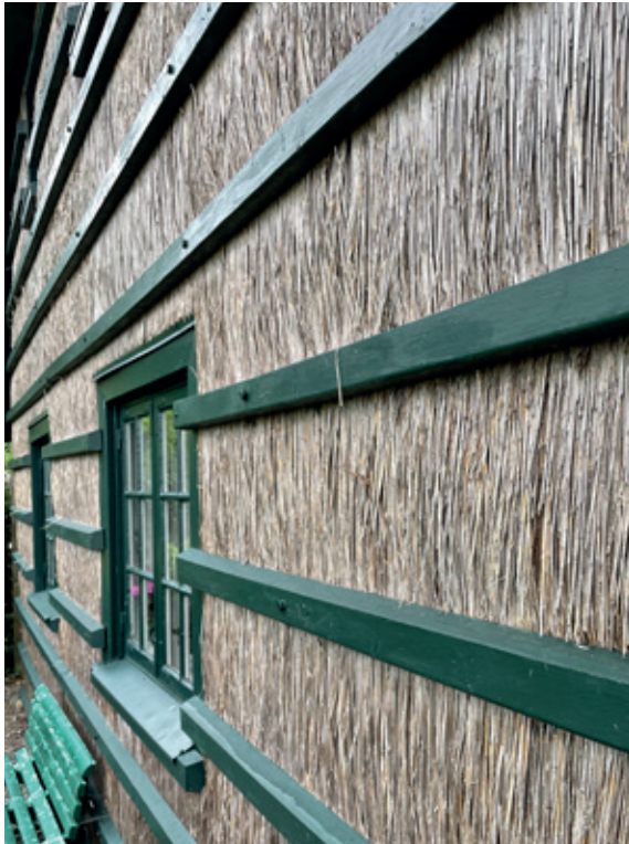
Listerne har en skrå overside for at vand løber væk fra tækkerørerne. © Thorbjørn Lønberg Petersen
