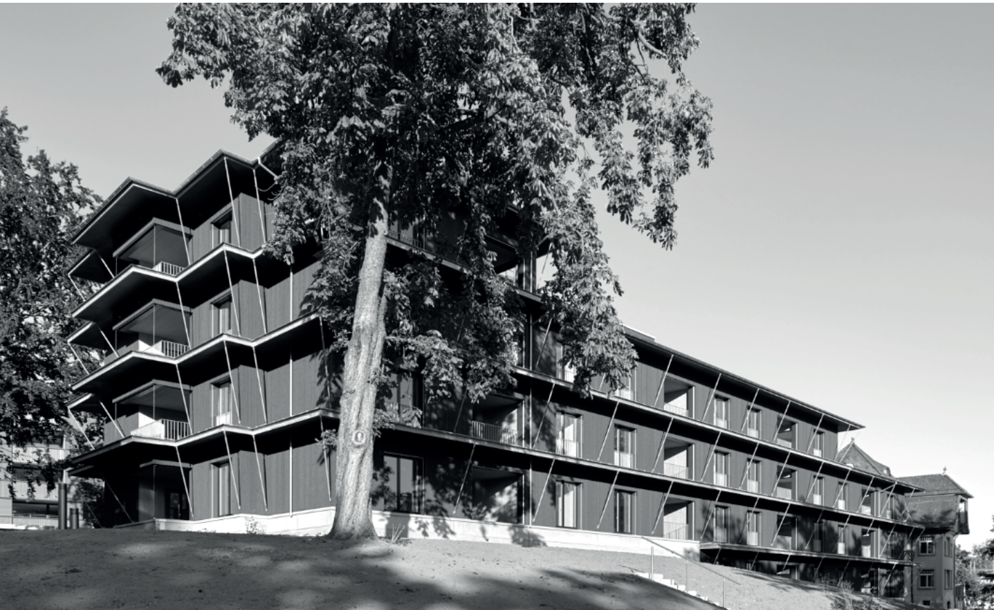
Udkragningerne følger husets omkreds, og har i princippet den samme dybde hele vejen rundt om bygningen, bortset fra ved de overdækkede terrasser for enden af bygningen. På tagterrassen er den bærende konstruktion synlig. © Yohan Zerdoun
