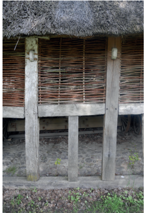
FIG 13: Bindingsværksfag på gård fra Fjelsted i Den Fynske Landsby. Øverst ses støjlerne i pil nedboret i løsholt og toprem. Herimellem er der flettet med vidjer. I de nederste tavler ses der ingen huller i tømmeret hvilket tyder på, at der her er anvendt en anden byggeteknik – f.eks. udmuring med ubrændte lersten. © Henriette Ejstrup, 2024
