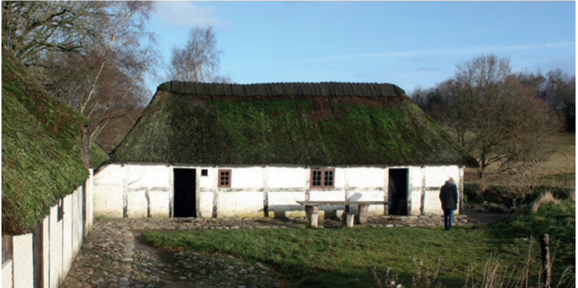
FIG 17: Kvostedhus på Hjerl Hede er en styrtrumskonstruktion, som har rørtækket tag. Bygningen kommer fra en egn, hvor det har været almindeligt at anvende tørv som mønning. © Henriette Ejstrup, 2015
