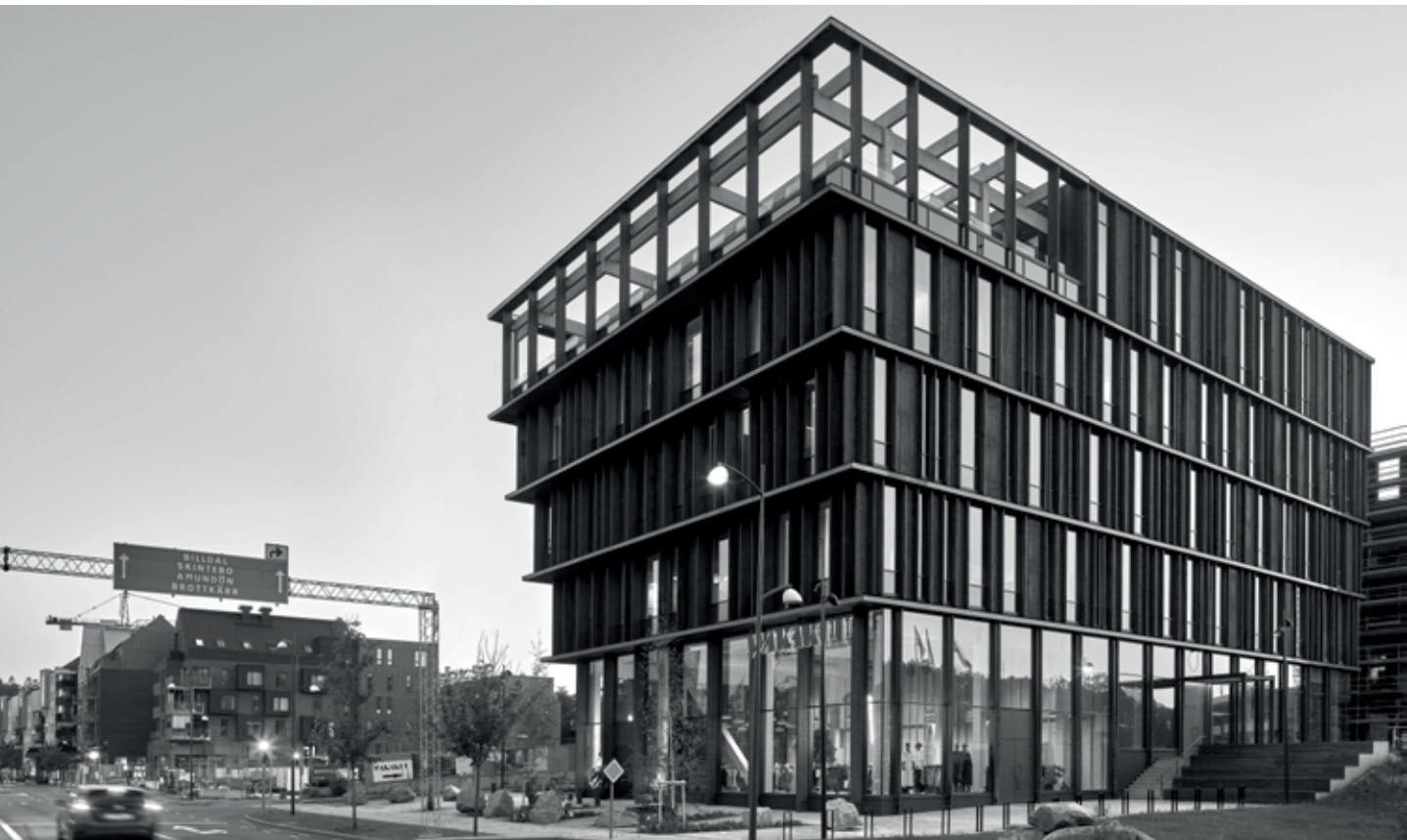
Bygningernes etager udkrager mod syd mens facaderne mod nord er udført med gesimser i samme niveau over hinanden. På tagterrassen er den bærende konstruktion synlig. © Åke E:son Lindman
