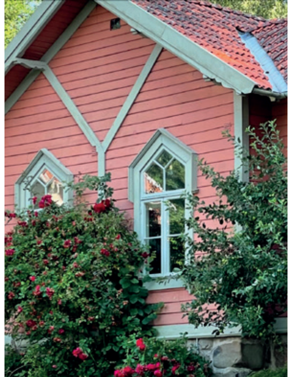
Vandbrædder over vinduer er også et taknemmeligt emne for Snickareglädje. I dette eksempel kan man pege på dobbelt konstruktiv beskyttelse, hvor vand som løber ned af facaden over vinduet både vises væk fra facaden, og til siderne. © Bygnadsverk.se
