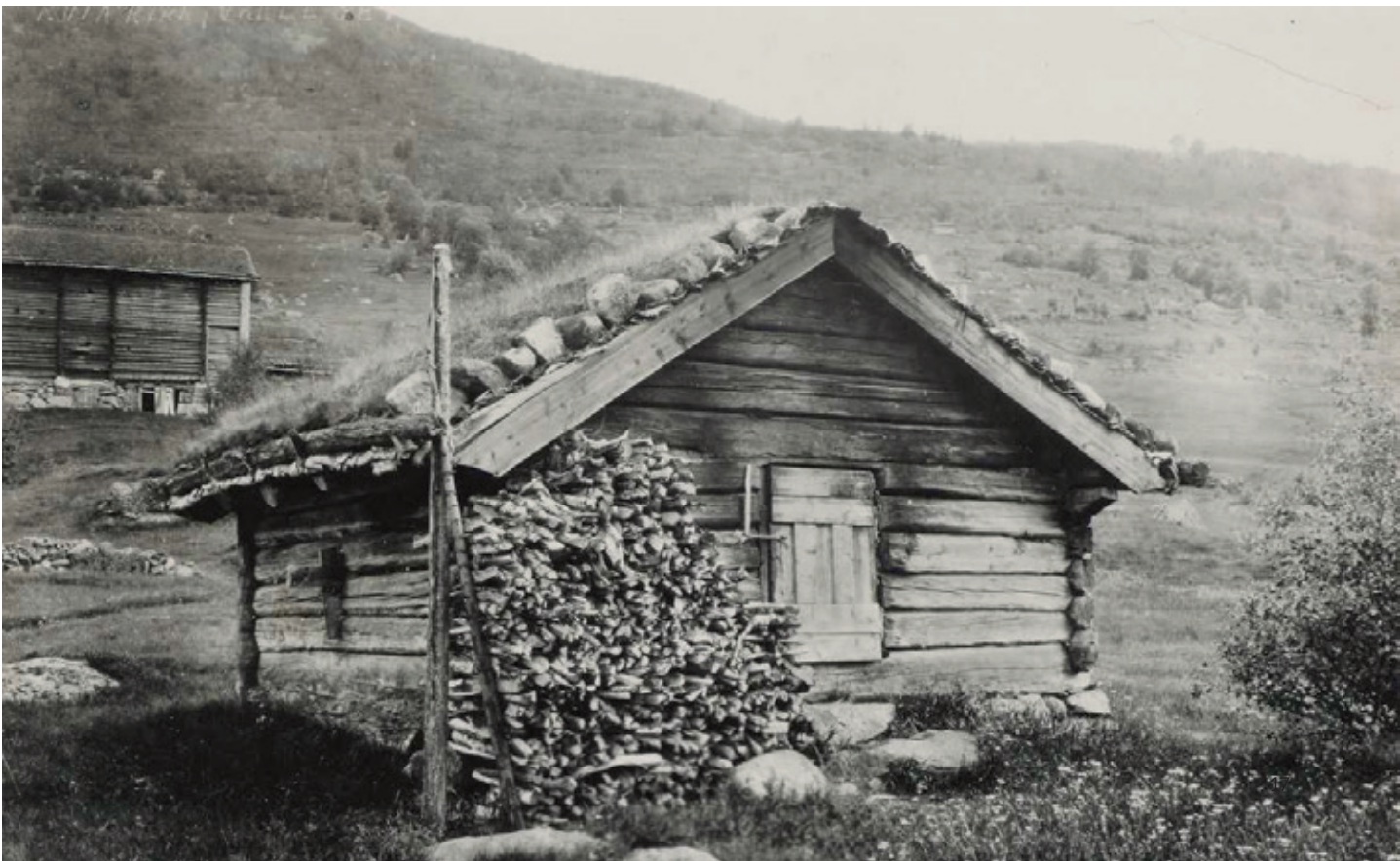
FIG 1: Badstue fra Setesdalen opført som blokhuskonstruktion med rundede knuder. Stokkene er let afrettet. I baggrunden anes en fleretages gård med højt fundament i sten, hvori der også er indlagt funktioner. Henrik Vensild ca. 1900. © Nationalmuseets online samlinger
