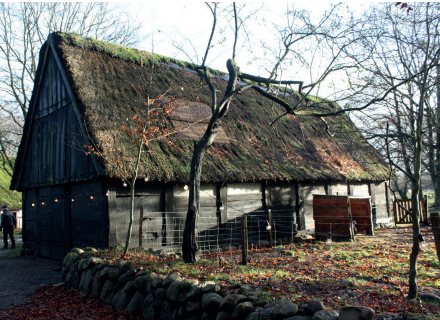
FIG 14: Bullade på Hjerl Hede. Bygningen er udført med stolper, der er indtappet i bund- og toprem. Tavlene er udfyldt med egeplanker, som er notet ind i stolperne. På gavlen er brædderne dyvlet fast, hvor de kraftige, afrundede dyvler også er brugt som et dekorativt og gennemgående element mellem gavltrekanten og portpartiet. © Henriette Ejstrup, 2015
