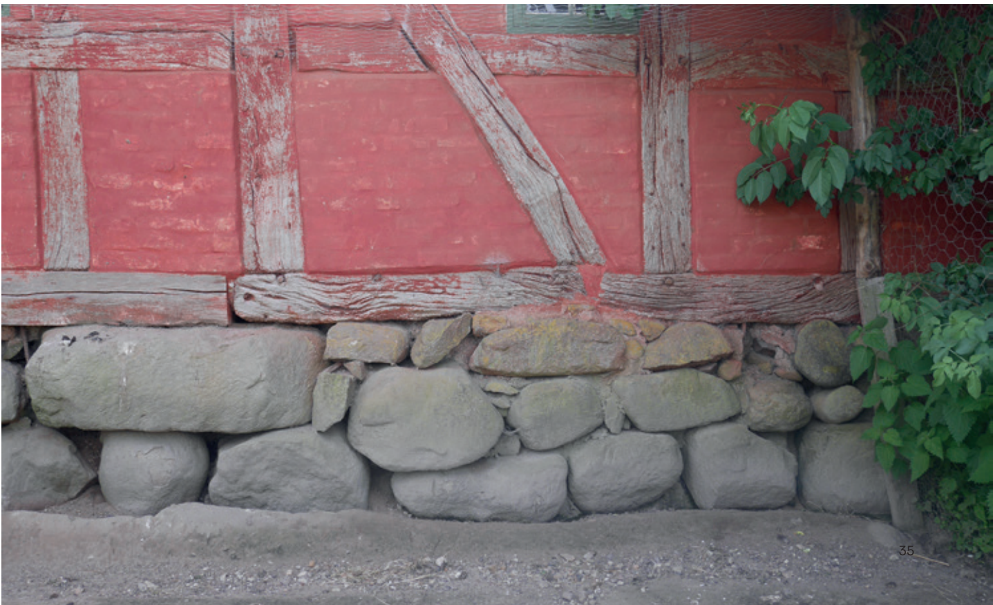
FIG 19: Præstegård fra Tommerup i Den Fynske Landsby har en høj sokkel lagt som en tærmur af utildannet marksten. © Henriette Ejstrup, 2024
