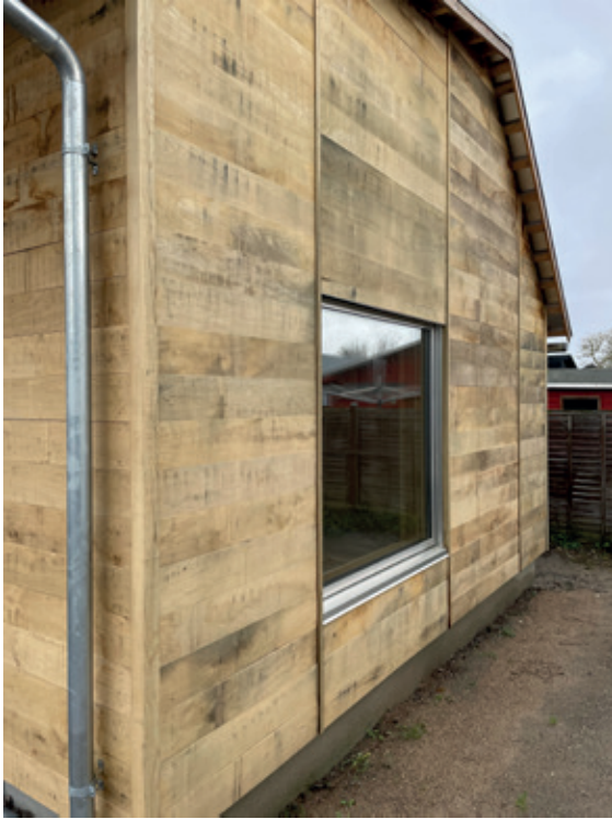
Ved hjørnerne afsluttes den vandrette beklædning med en bredere lodret og i tværsnit kvadratisk liste. © Anne Beim
