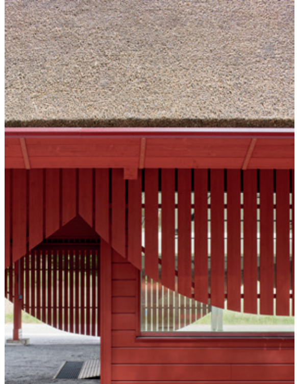
Det er et særsyn at se tækkede tage udført med tagrender. © Åke E:son Lindman
