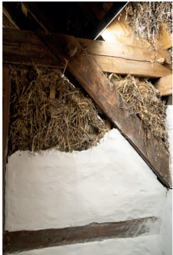
FIG 11: På Lynggården på Læsø er der anvendt lerklinede og kalket halmsime i tavlene. Simene er flettet omkring støjler som er notet ind i bindingsværkets løsholt og toprem. © Henriette Ejstrup, 2024
