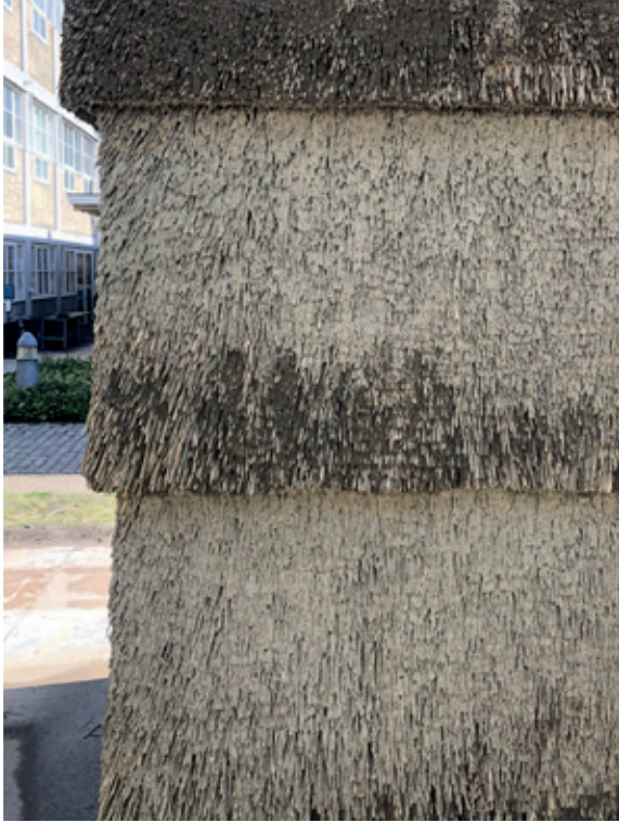
Den tækkede facade umiddelbart efter kraftig regn, hvor det tydeligt kan ses, at reliefet fugter op nederst og forbliver tørt øverst. © Cinark
