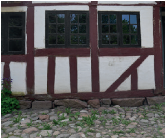
FIG 21: På 'træskomagerhuset' fra Vigerslev I den Fynske Landsby ses et let tildannet fundament i kampesten, der hæver bundremmen op over terrænet. Terrænet er brolagt med pigsten, som afhjælper opsprøjt fra regn ved at slå dråberne i stykker samt hjælper med vandafledningen ved at stenens 'korteste' side er lagt vinkelret mod huset, og derved leder vand ned langs stenenes 'lange' side. Bundremmen er sammensat af flere tømmerstykker sammenføjnet af bladsamlinger. © Henriette Ejstrup, 2024
