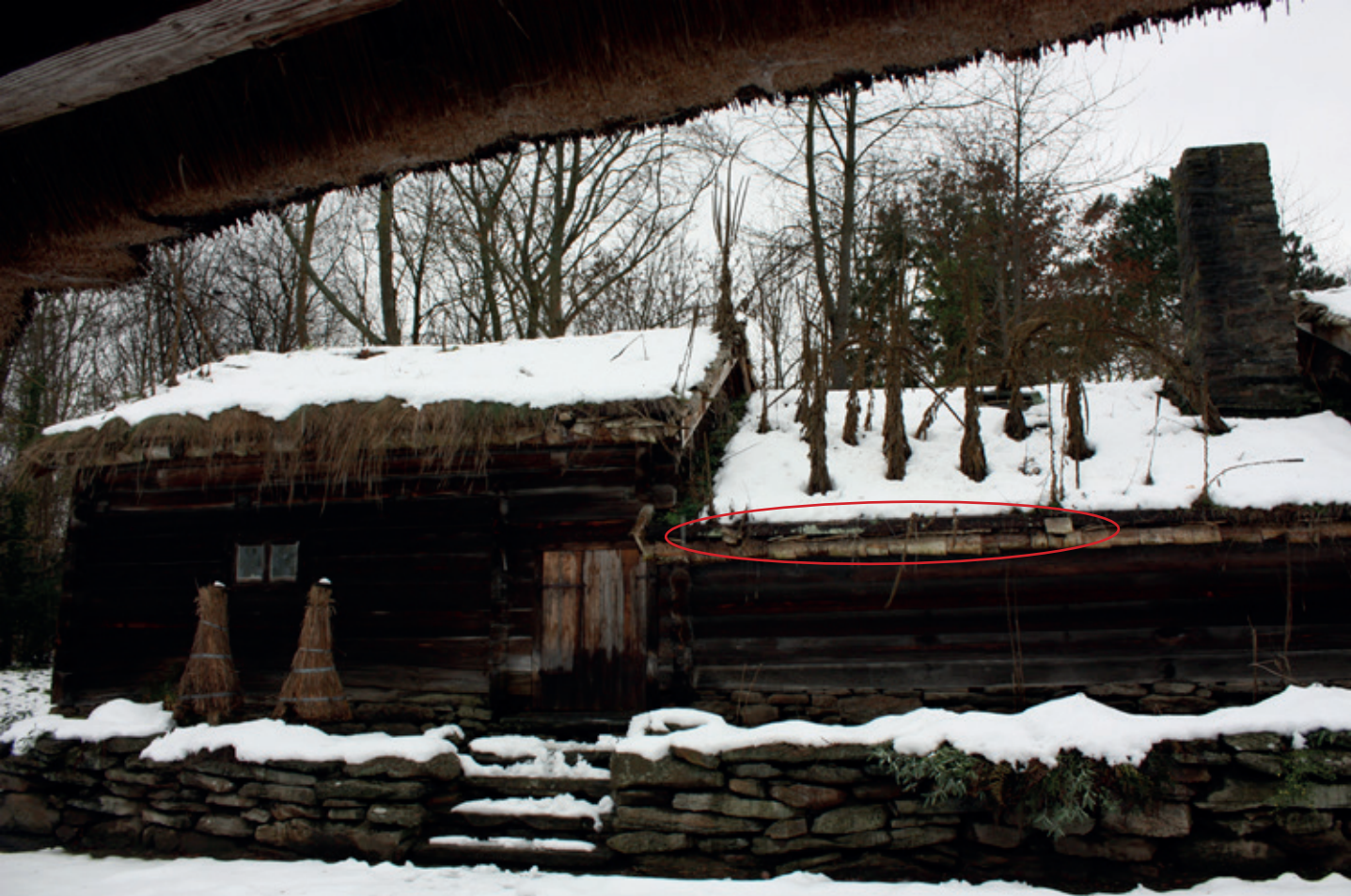
FIG 6: Træ af græstørv på gård fra Halland på Frilandsmuseet. Næverne af birkebark, som lægger under græstørvene er ført ud til tagskægget og bukket neden om rafteenderne for derved at beskytter dette udsatte knudepunkter i konstruktionen. © Henriette Ejstrup, 2015
