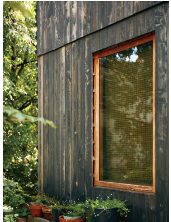
I vindueslysningerne bliver de skrånede afstandslisters også til et dekorativt element. © Ty Cole
