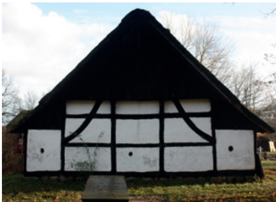
FIG 20: Vinkelgården på Hjerlhedede er opført som en højremkonstruktion, hvilket afspejler sig ved bindingsværkets aftegninger i gavlen, hvor to højstolper ses i andet til fjerde fag, mens de første og sidste fag i konstruktionen er udført som en tilbygning hertil, udsået. Gavlens bundrem lægger af på en række af syldesten, hvor hjørnestenene er let tildannet. © Henriette Ejstrup, 2015
