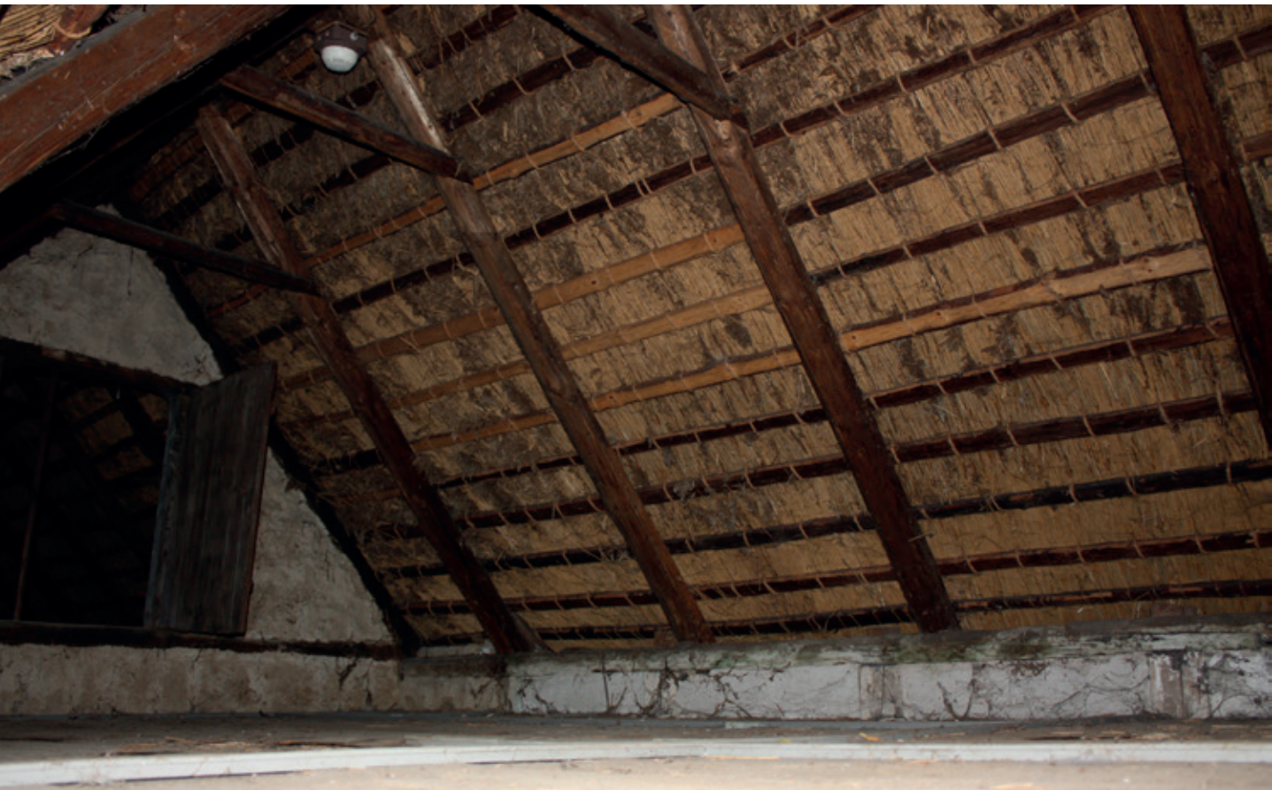
FIG 15: På gården fra Agger på Frilandsmuseet kan man i det indre af styrtrumskonstruktionen se stråtagets syninger med garn om de finske lægter. Som brolægning er der anvendt et lag af rør. Spærerne er indkæmmet i topremmen og fastholdes bl.a. af de indkæmmede hanebånd nær kip. © Henriette Ejstrup, 2015
