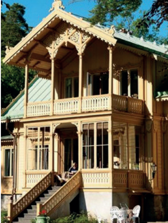
Verandaer er taknemmelige bygningsdele for Snickareglädje, da de har en åben karakter og ikke skal leve op til de mange krav som den bagvedliggende klimaskærm skal. © Bygnadsverk.se
