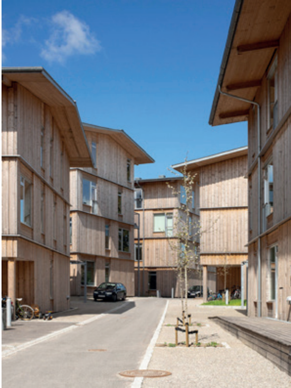
Over og under vinduerne er brædebeklædningen konsekvent vandret, modsat den ubrudte lodrette beklædningen mellem de etagevise vandbrædder. Det karakterfulde udhæng er udført i CLT elementer med brædder parallelt med førnævnte vandrette beklædning. © Helene Høyer Mikkelsen
