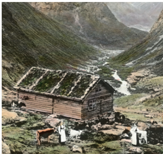
FIG 8: Blokhusbygget bondegård fra Norge, hvor fundamentet udligner et stærkt skrånende terræn og derved danner mulighed for en stald under beboelseshuset. V. Richter ca. 1920-30. © Nationalmuseets online samlinger.
