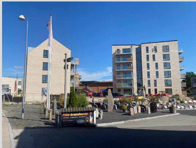
"Fjordbredden", 52 lejeboliger, på A.C. Hansensvej i Frederikssund tæt ved S-togsstationen. På nabomatriklen er der mindre erhvervsdrivende.
