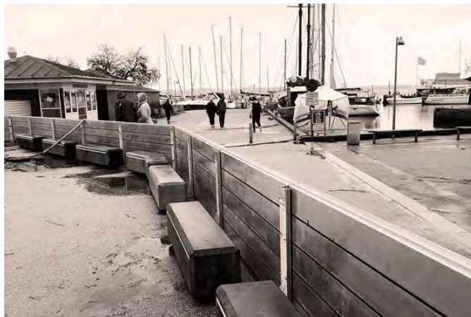
Reference: Mobilt system på Roskilde Havn monteret til stormflodsvarel
