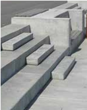
In-situ støbt beton-trappe
