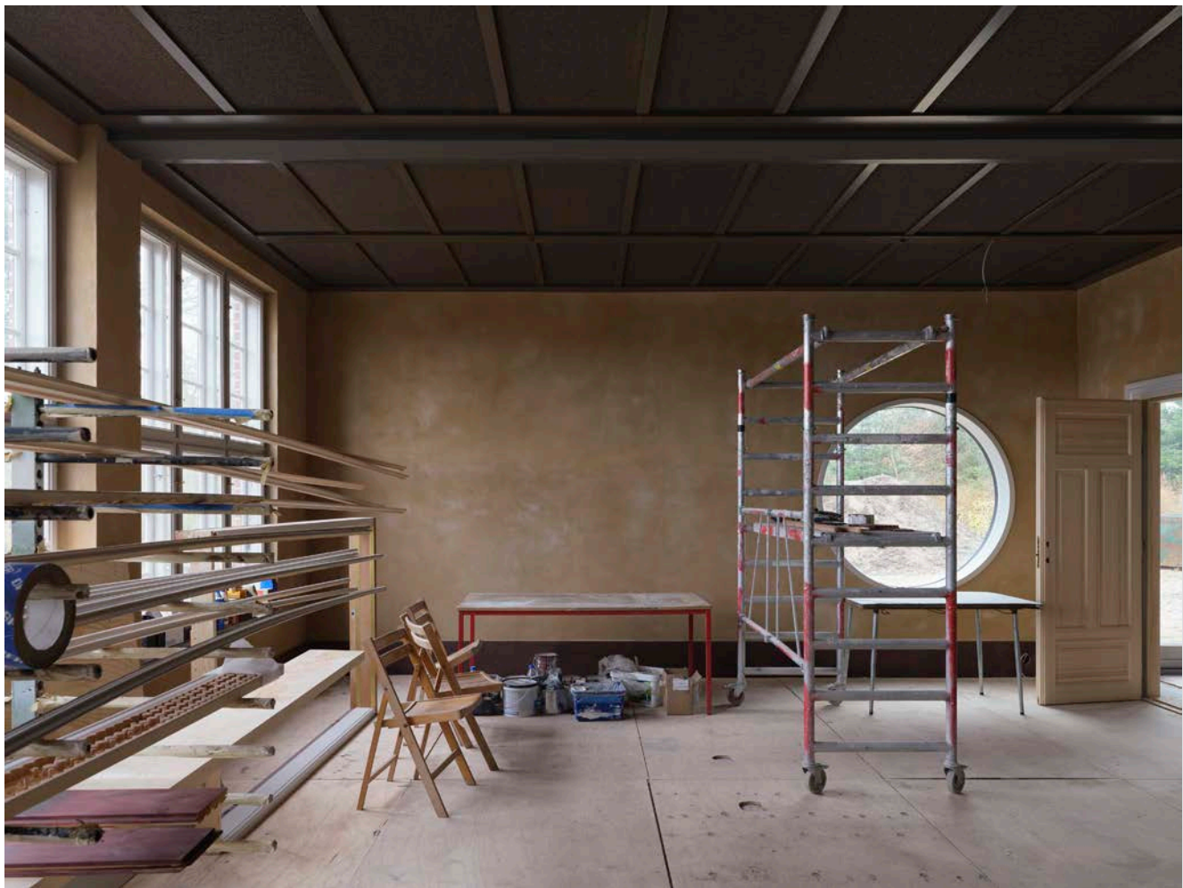
↑ Billede af skolestuen/formidlingsrum under udførelse
