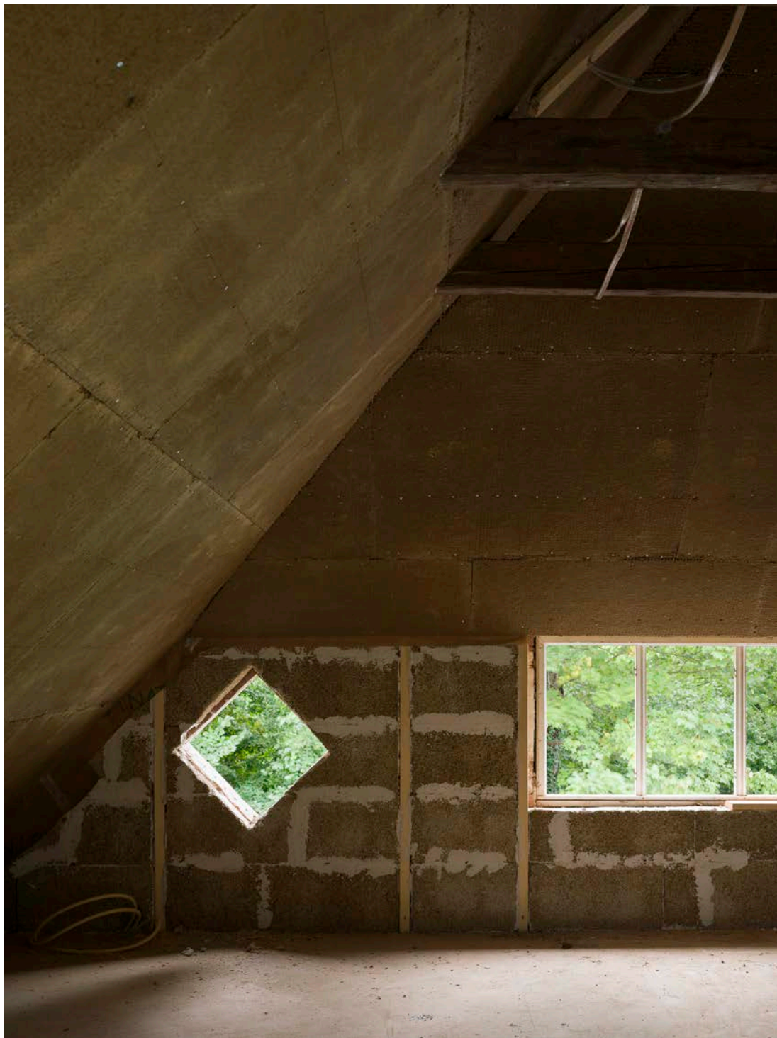
↑ Øverst: Hempcreteblokke brugt som efterisolering. Lerplader som afslutning på 1. sal Foto: Hampus Berndtson
