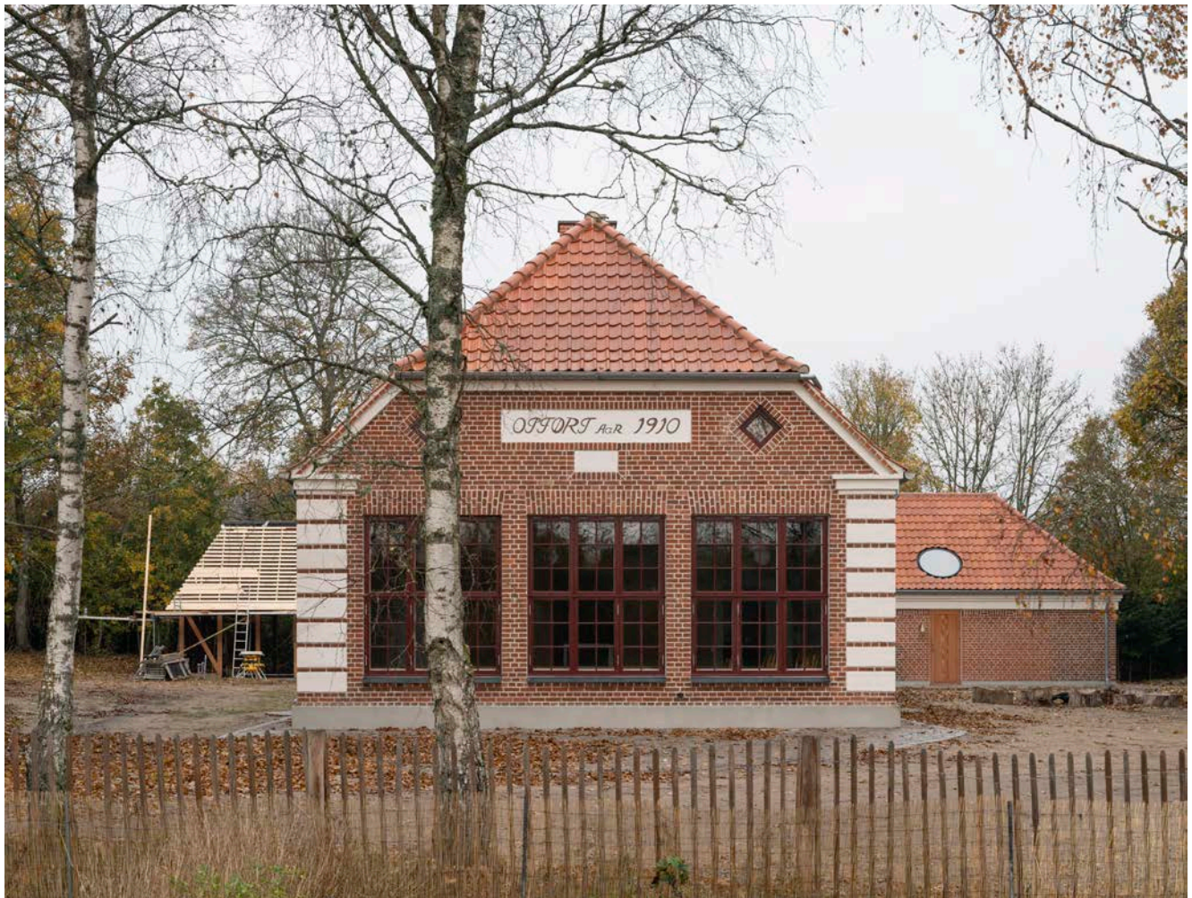
↑ Øverst: Hovedbygningen under renovering Foto: Hampus Berndtson
