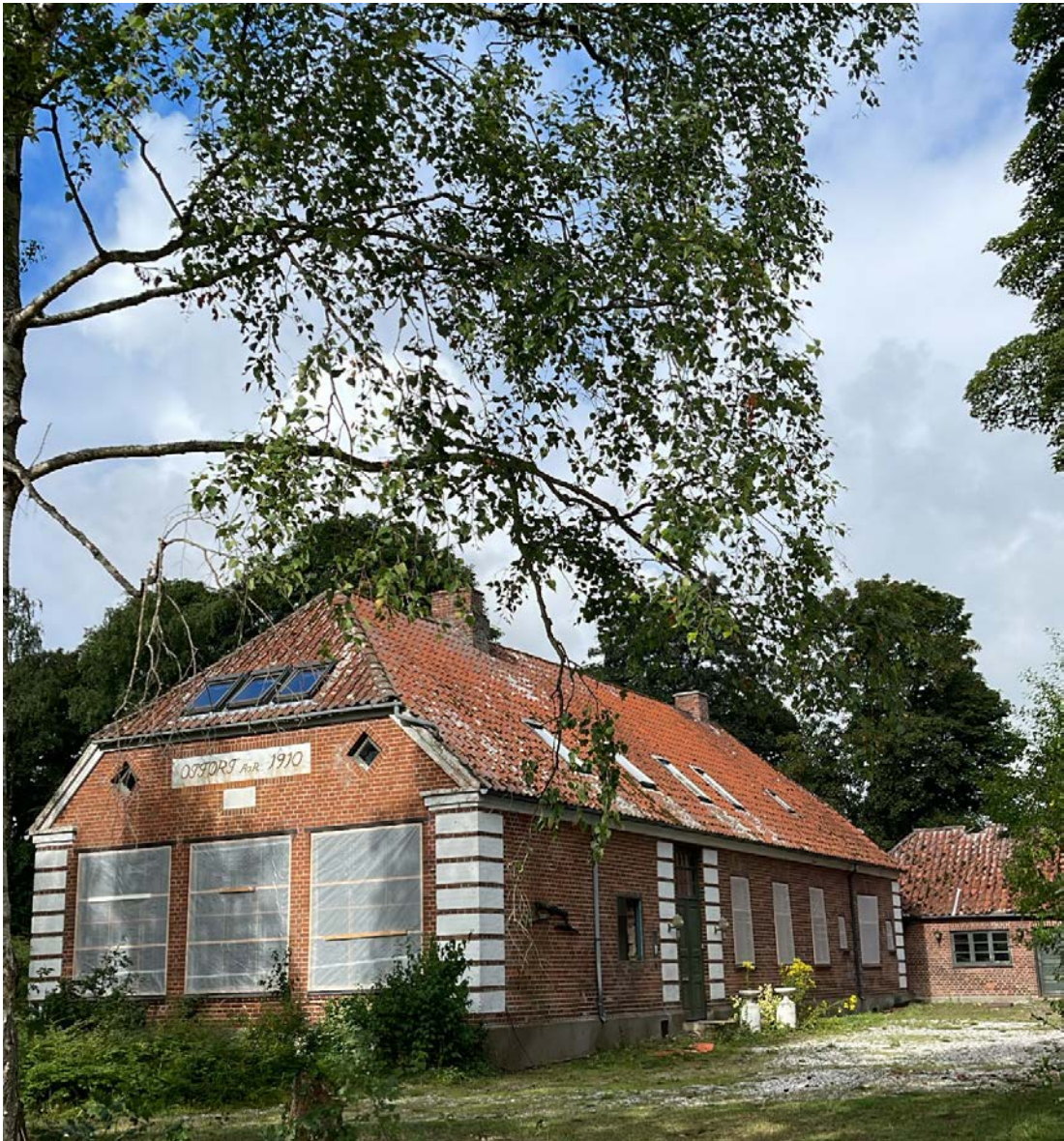
↑ Bygningen under renovering
