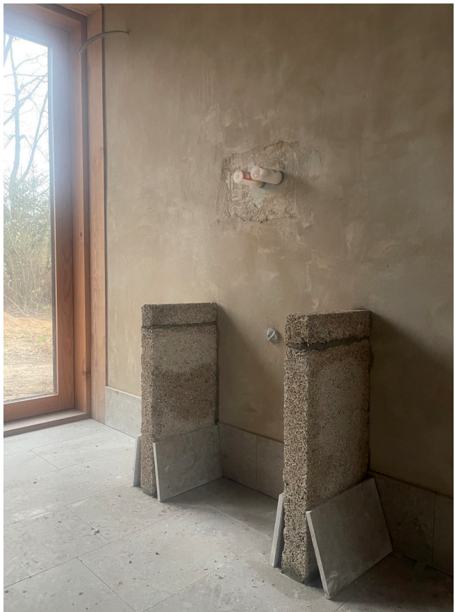
↑ Øverst th: Sol på højskabene Nederst th: Ben i hempcrete blokke
