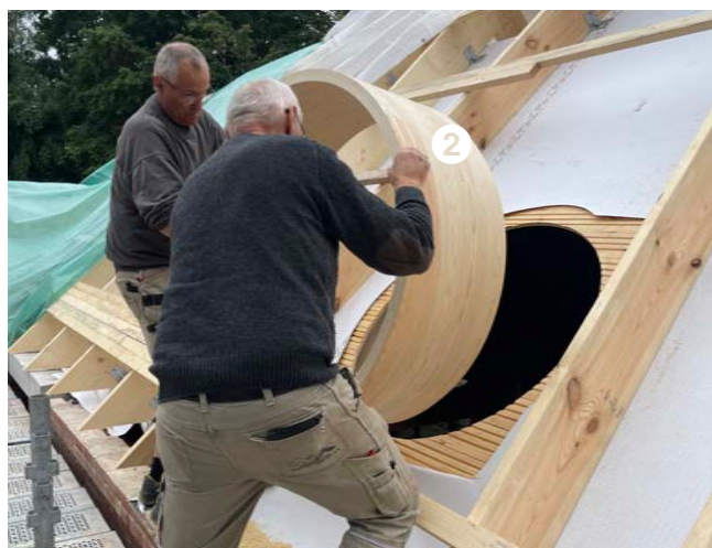
↑ Isætning af den runde vindueslysning i taget
