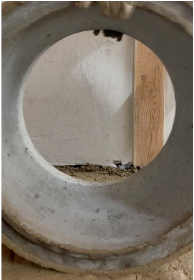
↑ Nederst tv: Jørn og Lasse spreder første lag lergulv Nederst th: Beton brøndring som erstatning for pladevibrator Fotos: Hedeskov
