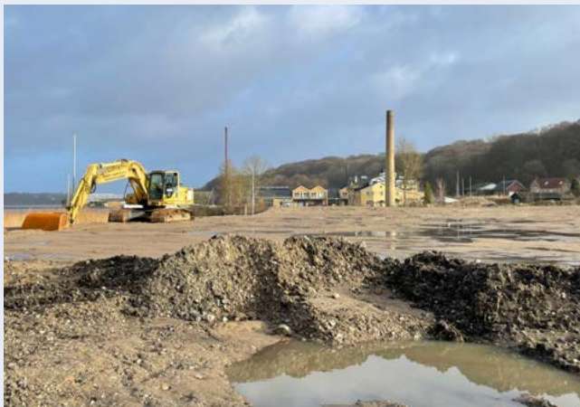
Hobro Terrænet hæves på de våde jorde. I processen ses de våde og vandmættede byggepladser.
