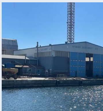
Assens Lagerhaller, materialer og funktioner der er relativt robuste i forhold til højere vandstande.
