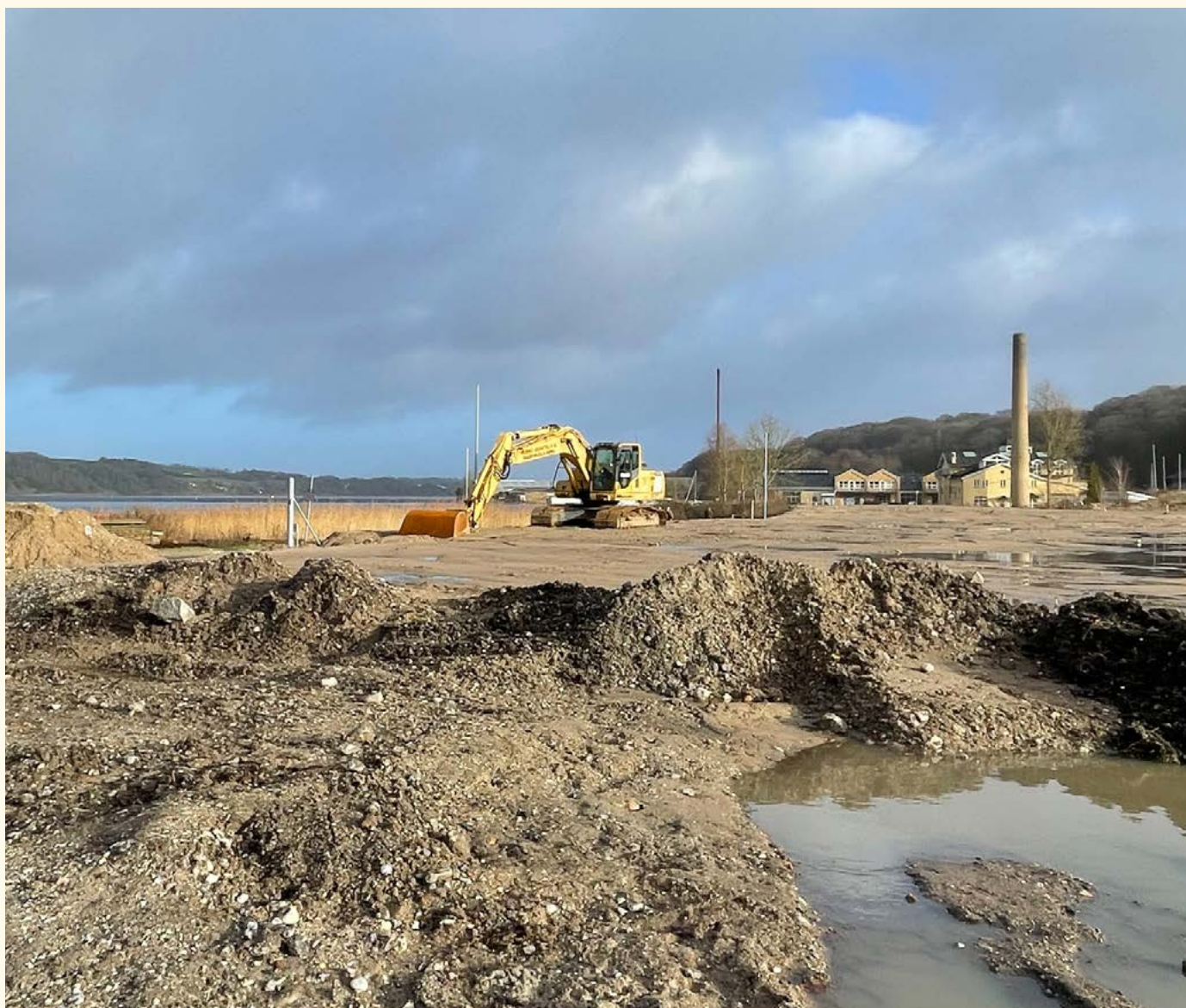
Figur 121: Der opfyldes på lavereliggende og vandlidende områder til ny byudvikling.
