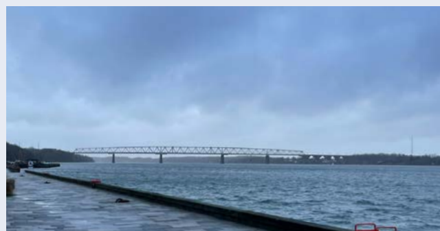
Middelfart To broer indrammer vandrummet.
