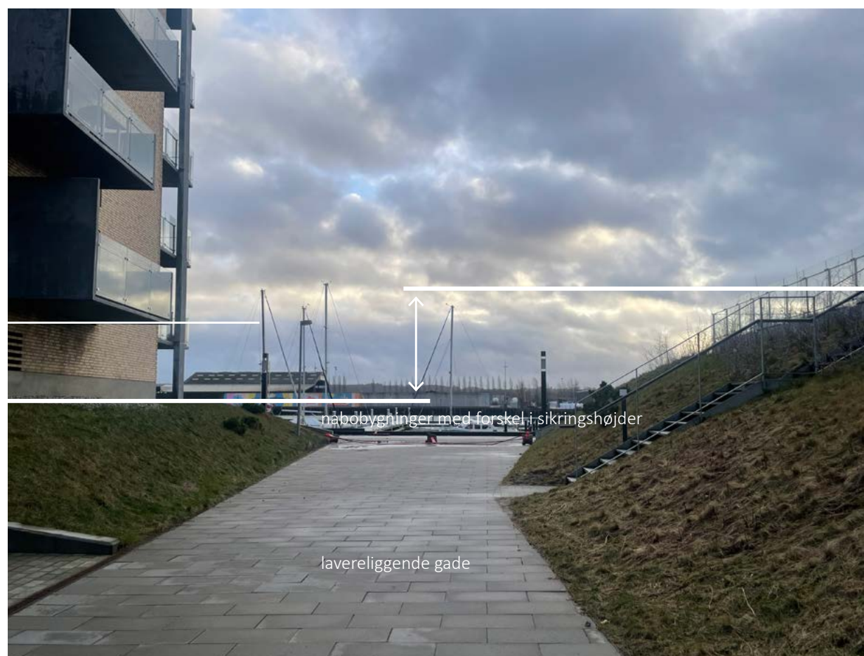
Figur 92: Diagrammatiserede fotos til eksemplificering af de varierende lokale sikringsniveauer.
