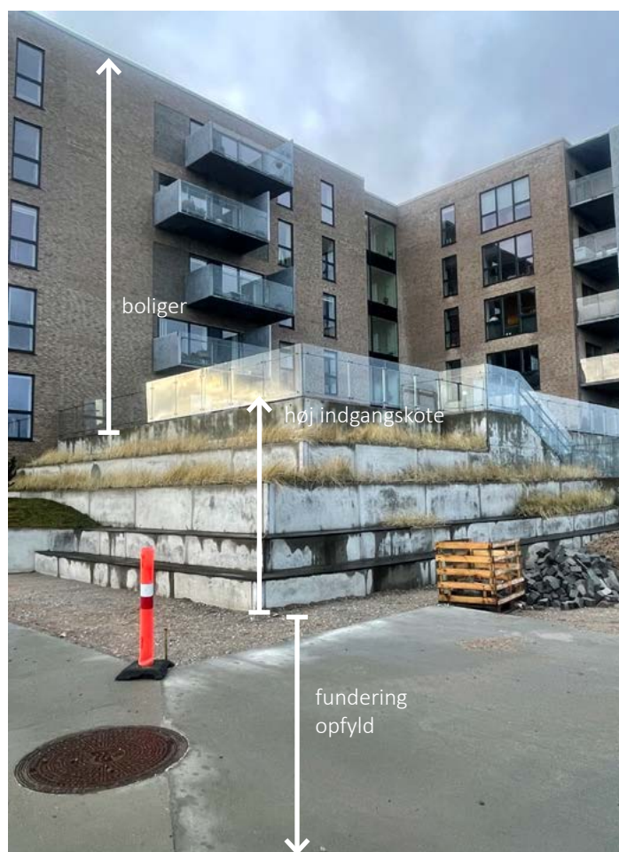
Figur 87: Diagrammatiserede fotos til eksemplificering af ekstra brug af ressourcer på blød bund, ved landvinding og til højere indgangskoter.
