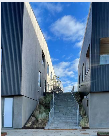
Holbæk Bygninger på fælles plint.
