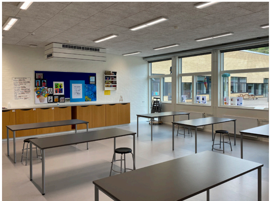
Renoveret faglokale med decentralt ventilationsanlæg, akustikloft, ny gulvbelægning, solgardiner og ny LED-belysning. Foto: Thoms Kjems Lyngvad, Silkeborg Kommune
