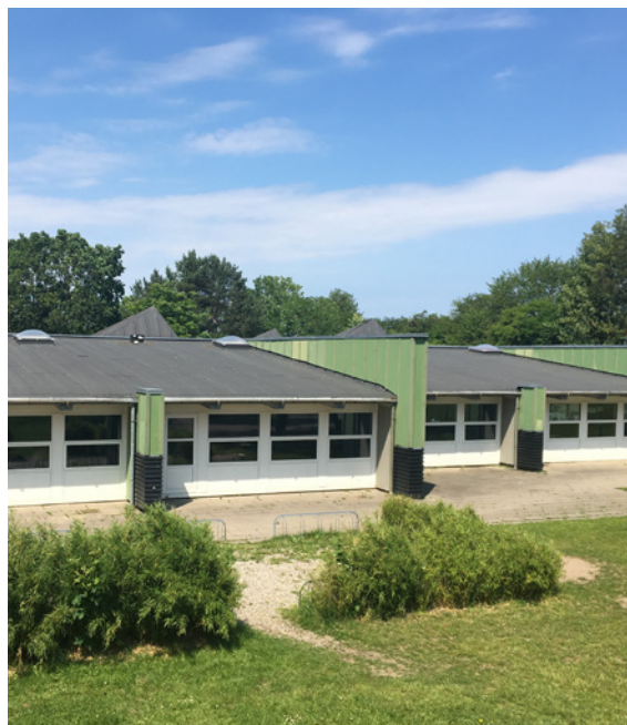
På Nordvestskolen er der efter screening blevet bevilget midler til renovering og forbedret ventilation. Foto: Helsingør Kommune
