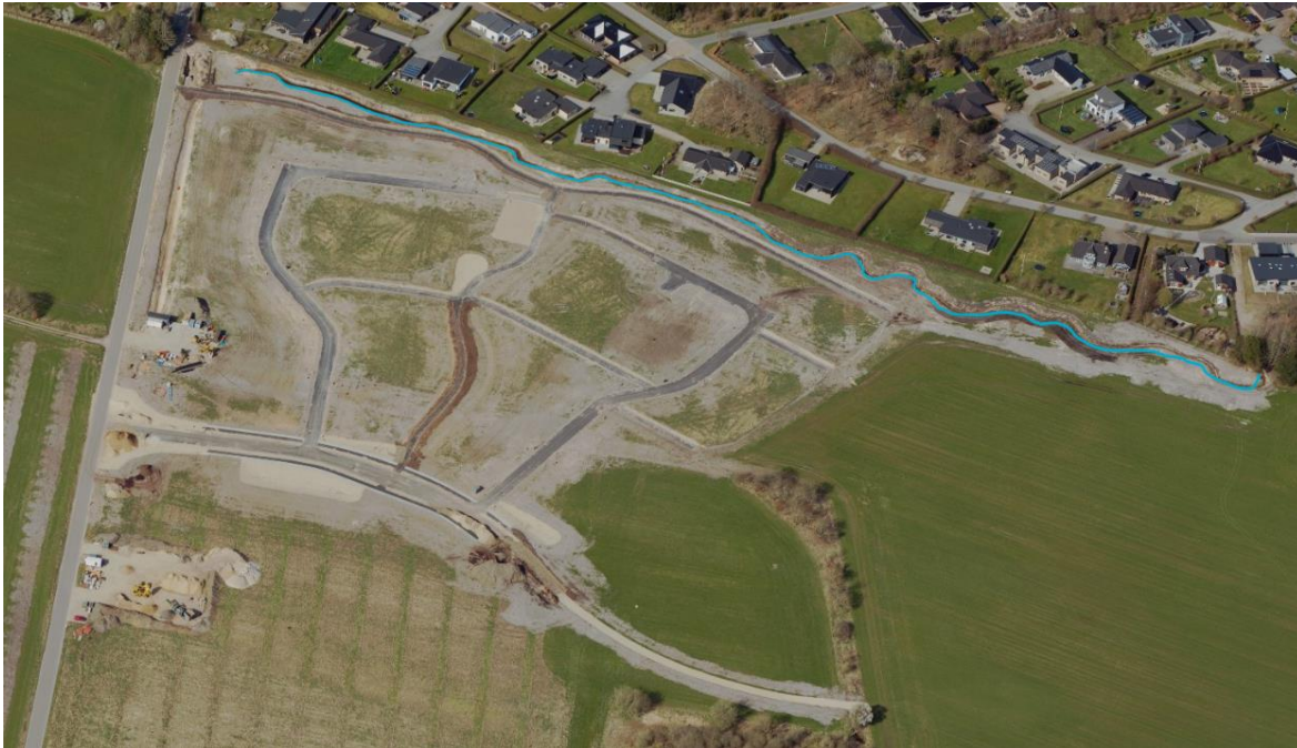
Et nyt vandløb – markeret med blå - ser dagens lys som en del af vandhåndteringen i en byggemodning ved Hyvildvej i Brande
