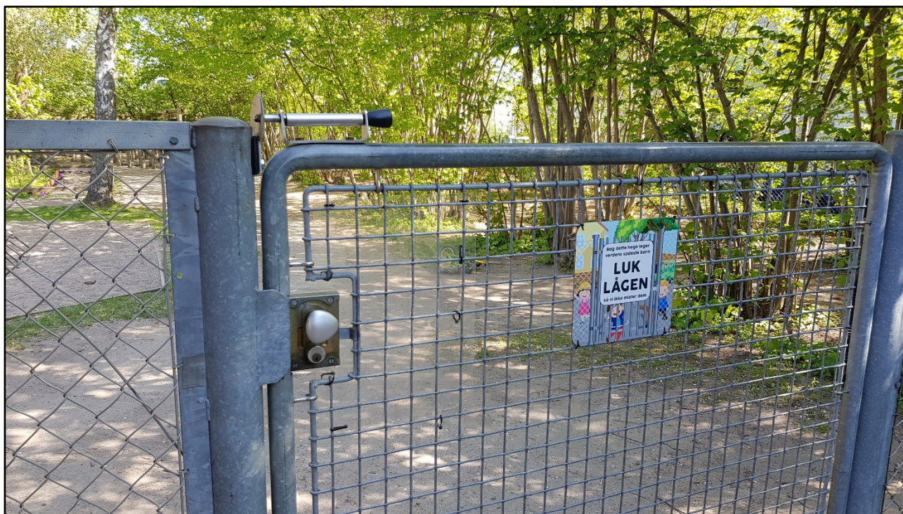
Figur 2: Den nye lukkemekanisme på lågen ind til legepladsen i Nøddehegnet.
