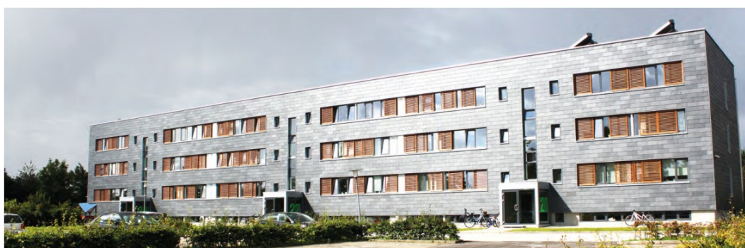
Figur 7 Billeder fra klimablok-renovering før og efter renovering. Projektfotos fra [146] venligst stillet til rådighed af AI2bolig.
