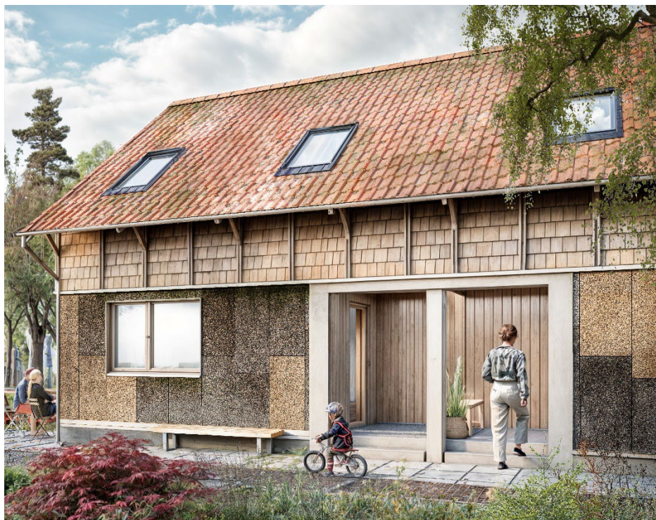
Figur 69 Biogen renovering – ca. 30 års patinering
