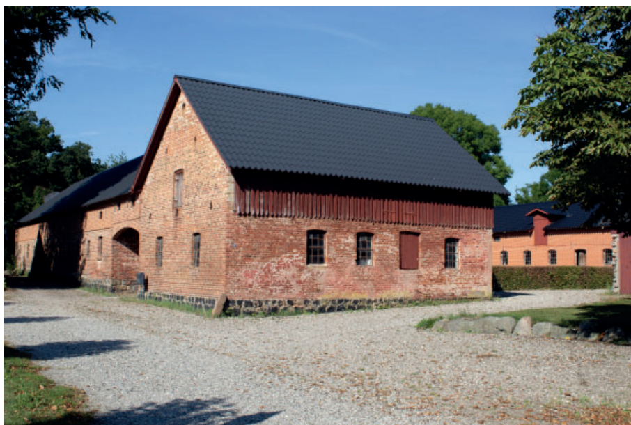
En gammel landbrugsbygning der tiltænkes en anvendelse som kollektiv i Tirstrup
