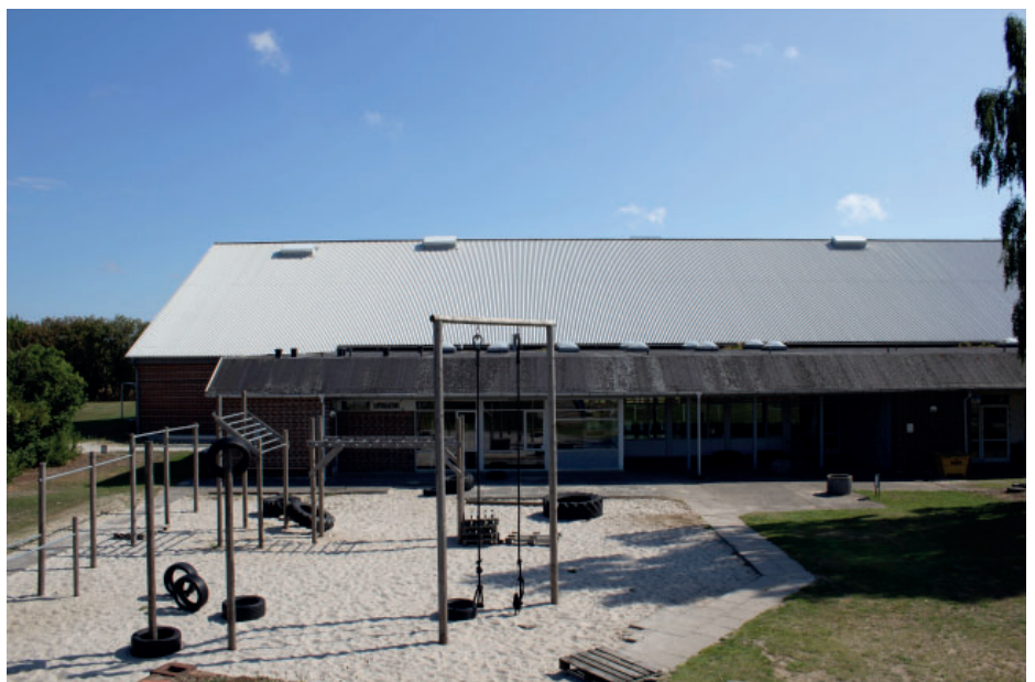
De bagvedliggende arealer på Tirstrup hallen indtænkes også i de nye planer for Verdensmåle- nes Hus som en aktivi- tetsplads
