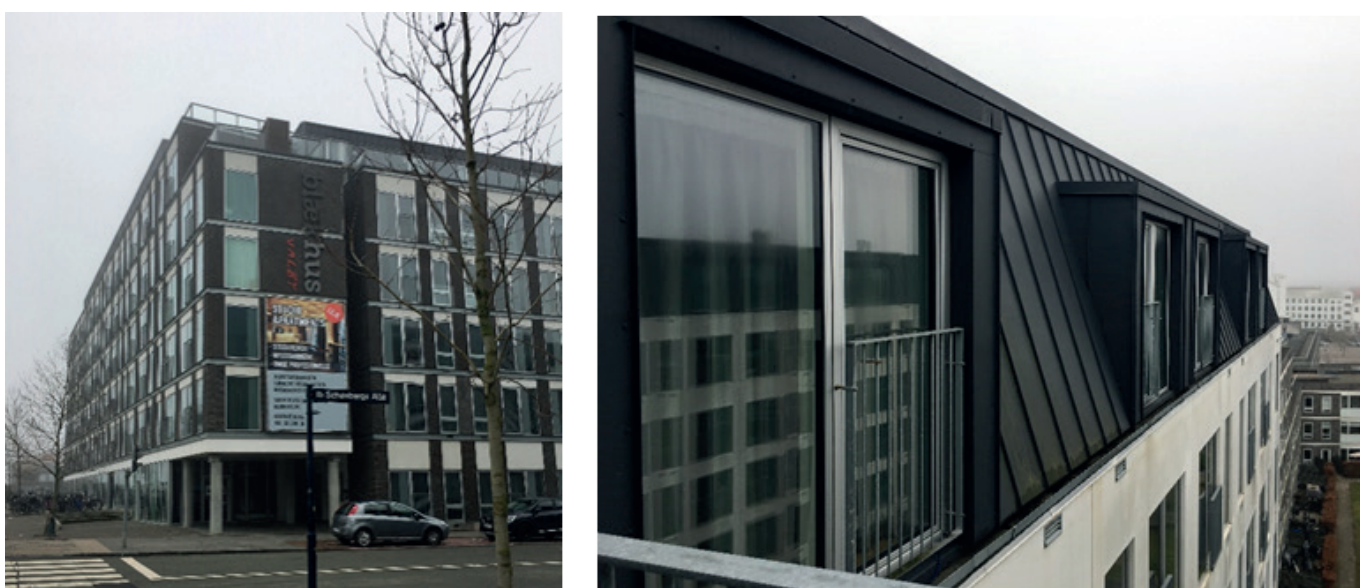
Figur 30. Blækhus Valby set fra hjørnet af Gammel Køge Landevej og Ib Schønbergs Allé i København (venstre) og fra tagterrassen (højre). Kredit: BUILD; AAU
