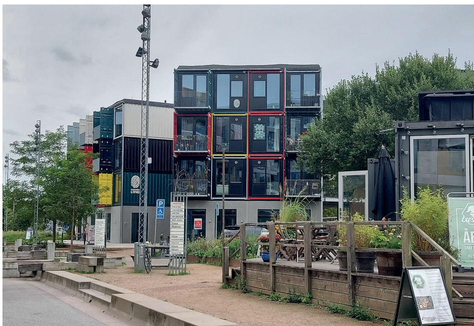
Figur 39. Container living i Musicon i Roskilde består af 30 lejligheder fordelt i tre punkthuse på henholdsvis 30 og 60 m 2 svarende til et eller to containermoduler. Fotokredit: BUILD.
