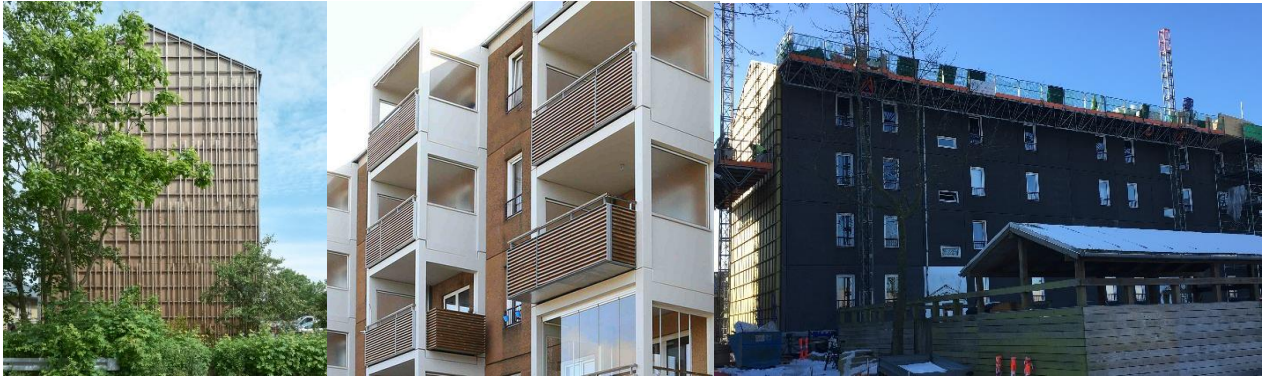
Figur 23 - billederne viser arbejderne på gavle, altaner og tages faktiske forhold og under og efter udførelsen af renoveringen
