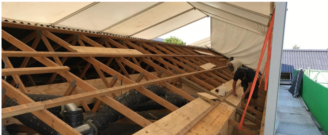
Figur 41 - Interimsforanstaltningerne på tag- og ventilationsprojektet på rækkehusene
