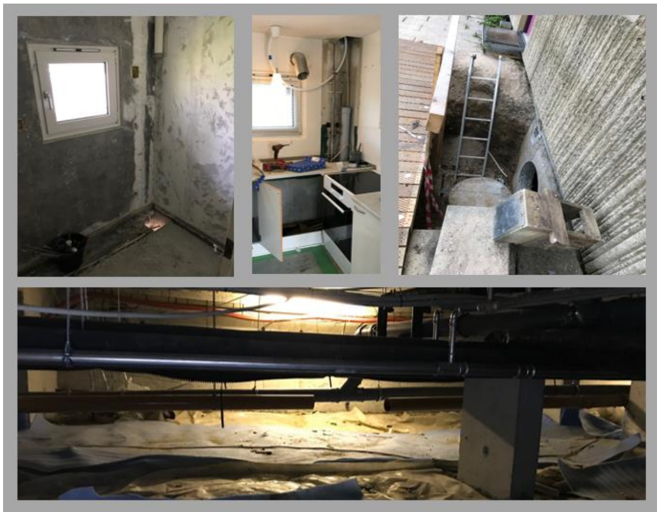
Figur 46 – Billederne viser forskellige rum og situationer. Øverst til venstre er badeværelset helt demonteret. Øverst midt ses køkkenet og de rørkasser som etableres til genvækst. Øverst til højre er mandehullet til VVS-folkene, som fortager udskiftningen af rør i krybekælderen. Nederste billede viser rørarbejdet i krybekælderen. Krybekælderen løber under hele rækkehusblokken.
