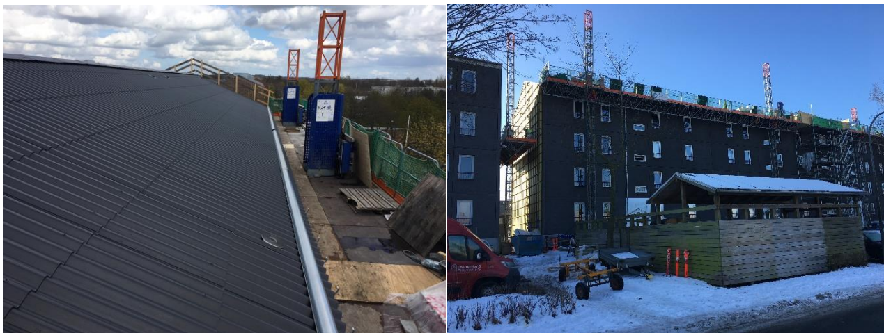
Figur 29 - Billeder af tagentreprise på etageblokkene og arbejdsplatformene
