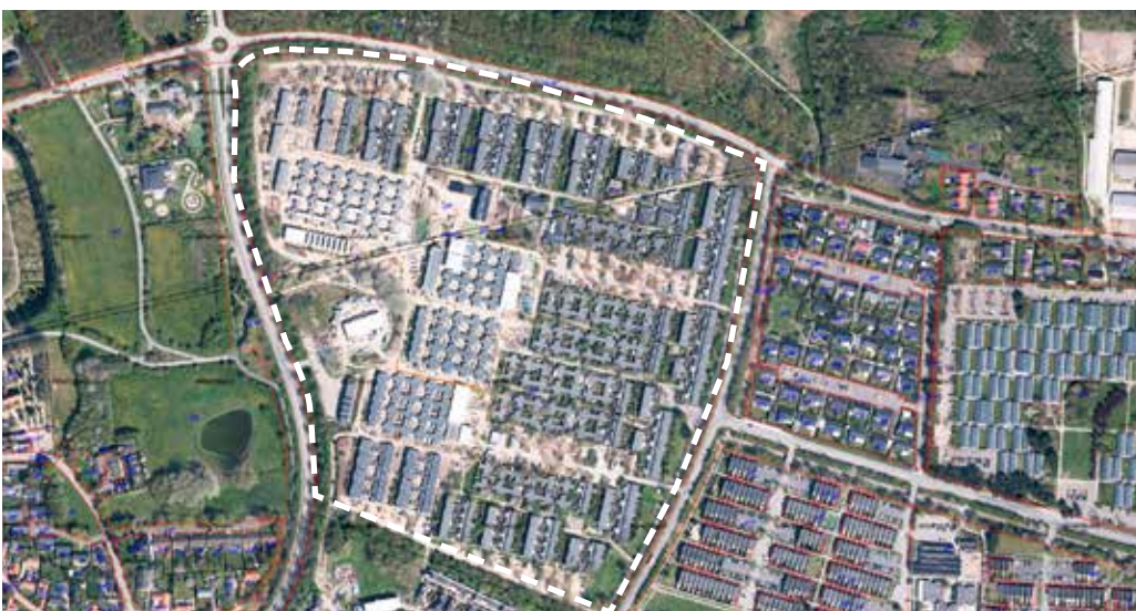
Galgebakken, Albertslund. Boligområde opført fra 1972-1974 med ca. 600 boliger fordelt i rækkehuse adskilt af stræder, legepladser, stisystemer og græsarealer.
