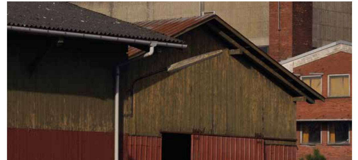
I forgrunden ses ladebygningen til Klostergården, og i baggrunden ses en del af DLG's bygningskompleks.
