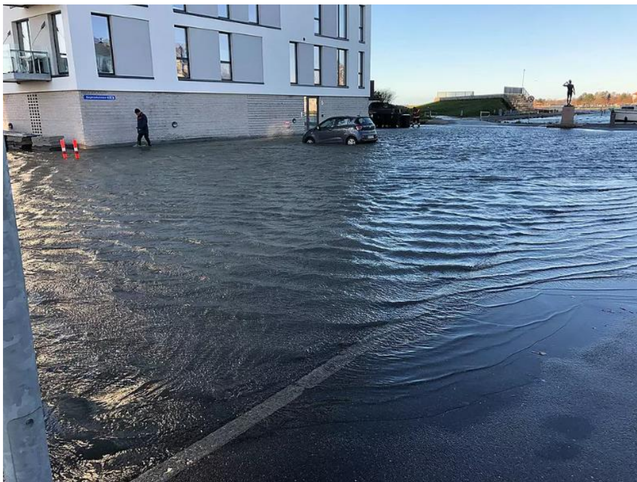
Figur 2-3: Oversvømmelser under stormfloden den 2. januar 2019. Det var stormen Alfrida, der var skyld i stormfloden.
