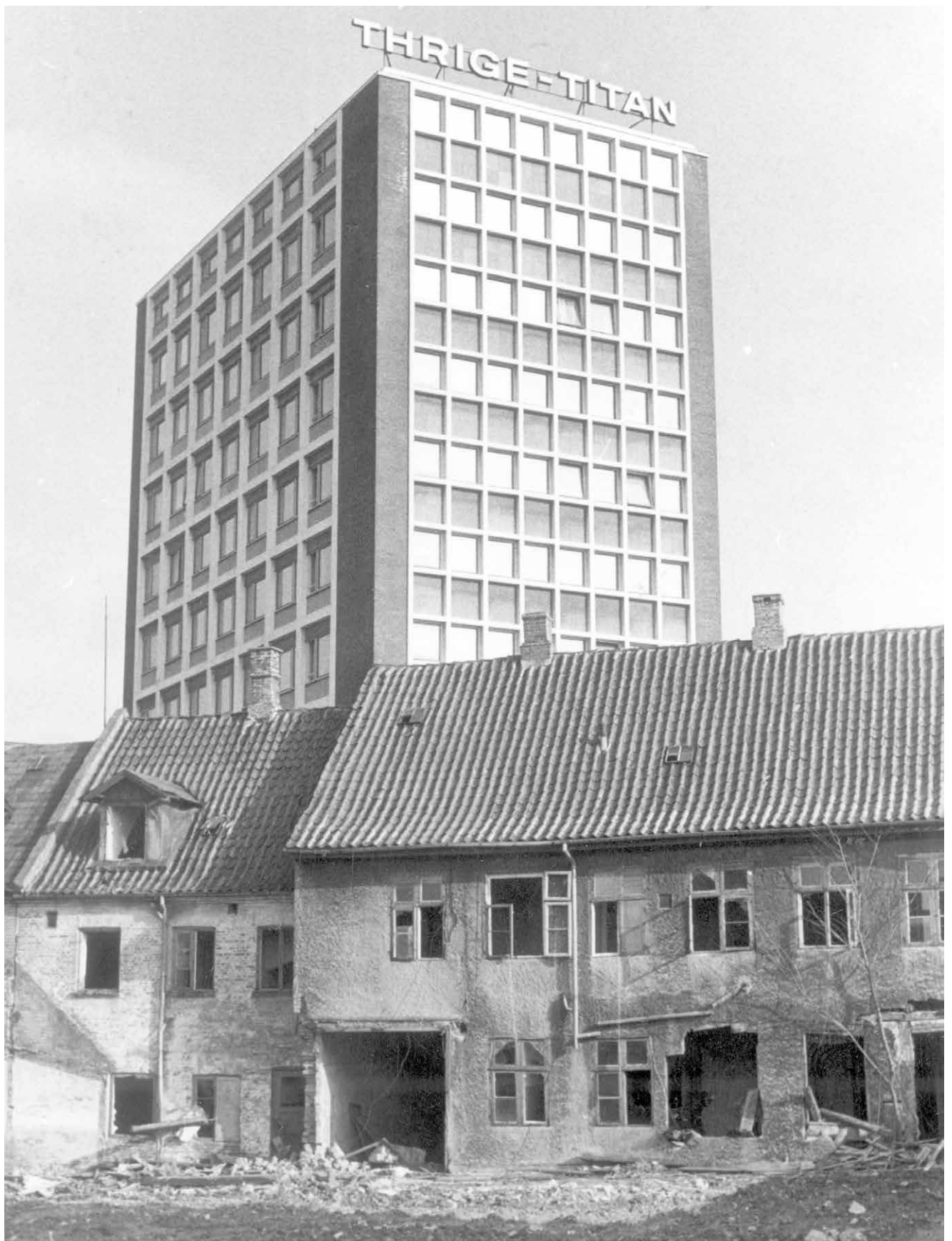
Nørrebroejendomme under nedrivning i forbindelse med etableringen af motorgaden. I baggrunden ses Thriges administrationsbygning.
