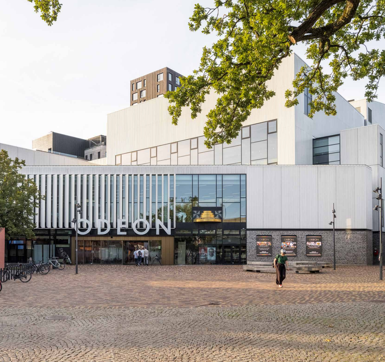
Etablering af plads foran det nye Odeon. Mødet mellem forskellige belægnings skaber et varieret udtryk.
