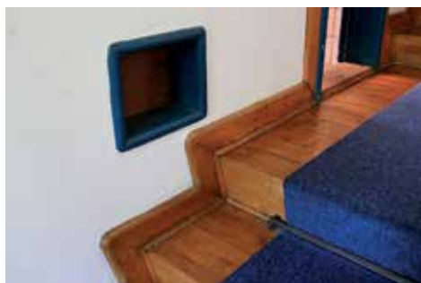
Detalje fra en indvendig trappe med nedfaldsskakt til vasketøj.
